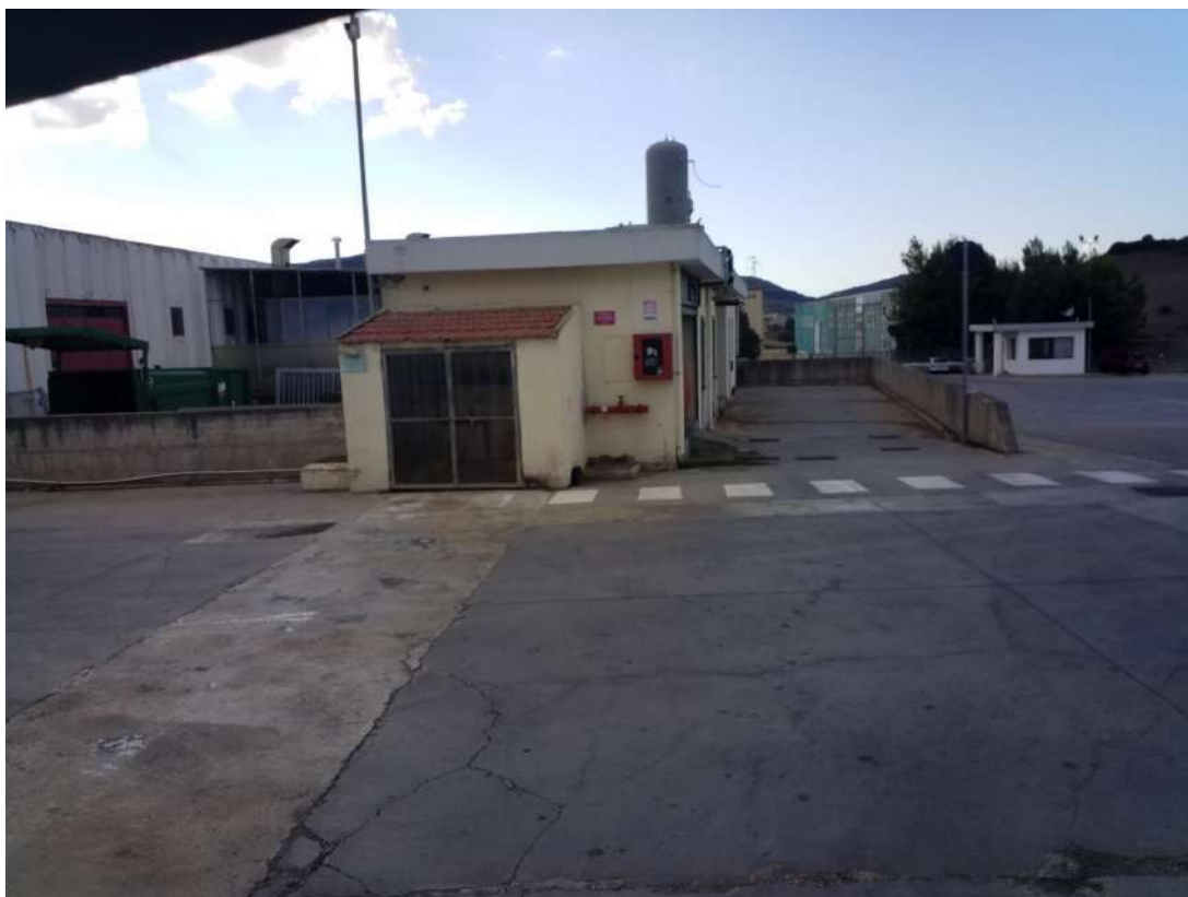
Ingresso principale lato Ovest locale tecnico e guardiana
