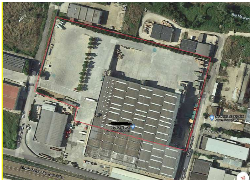
Posizione del Capannone sulla SS131
