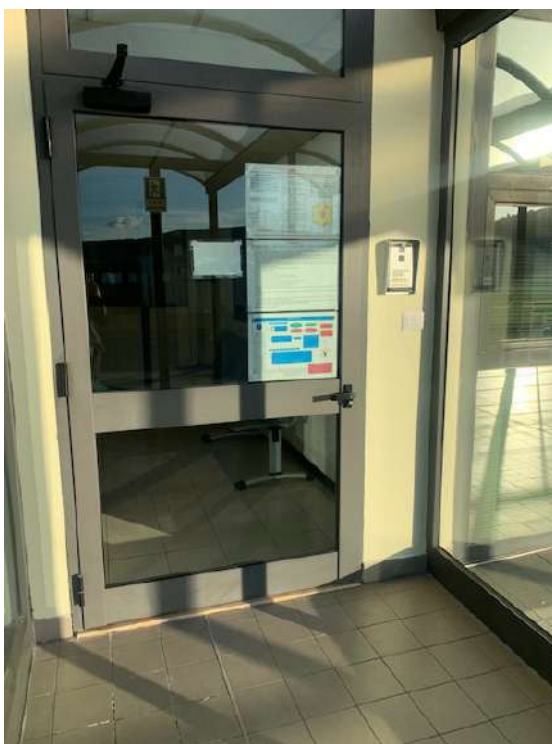
Accesso pedonale area uffici lato Ovest Piano Terra
