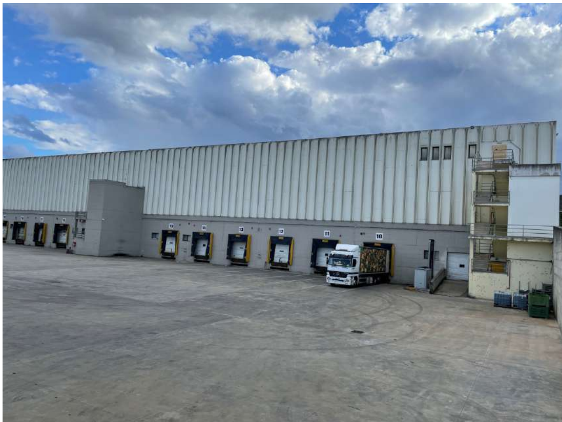
Vista esterna capannone lato Nord
