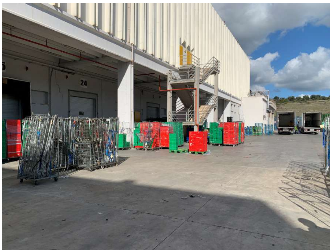
Scala sul lato est
