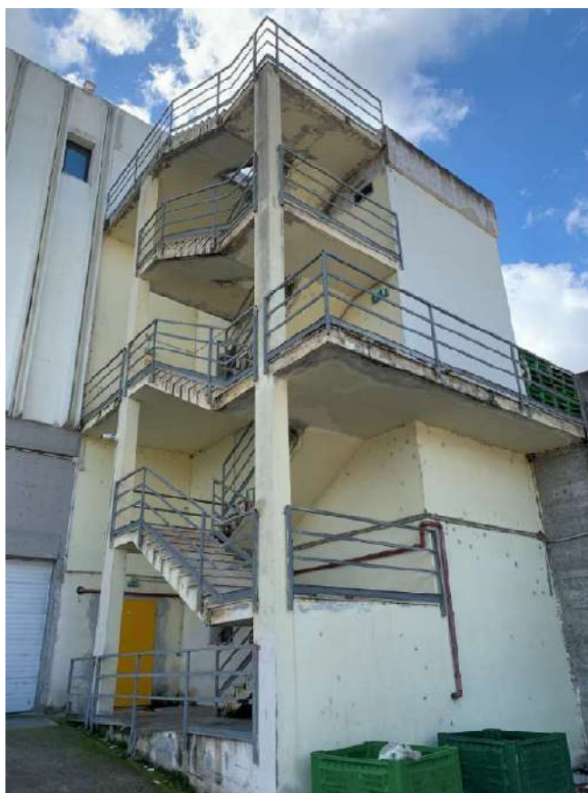
Scale esterne lato nord
