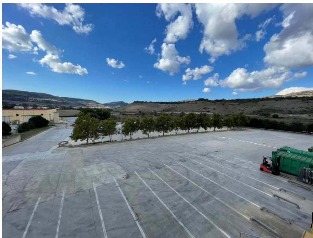
Vista sul piazzale lato Ovest, con ingresso su strada 5
