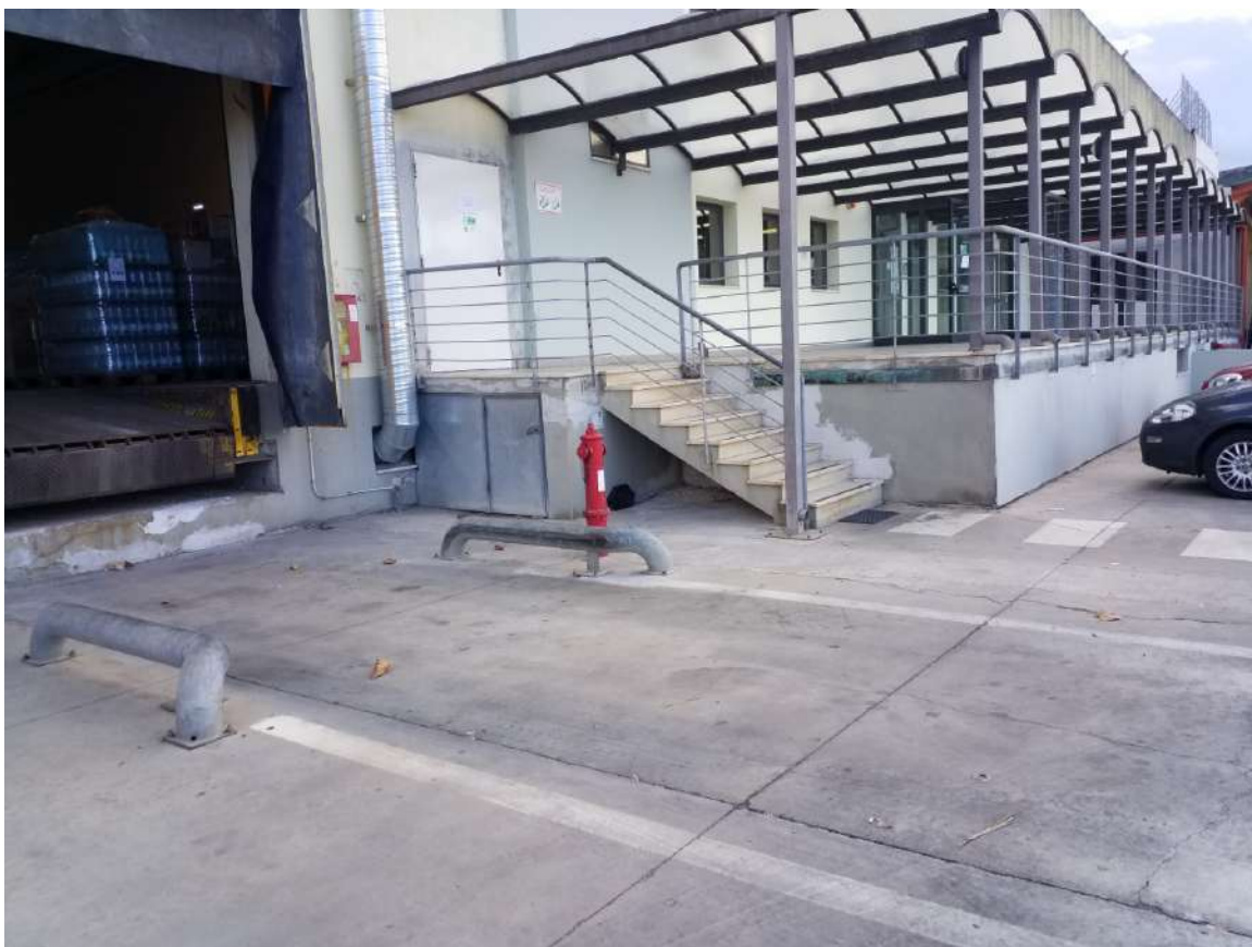
Accesso pedonale area uffici lato Ovest capannone piano terra
