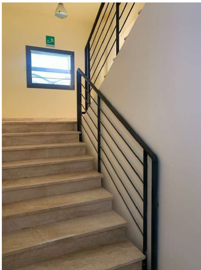
Vano scale dopo ingresso ascensore
