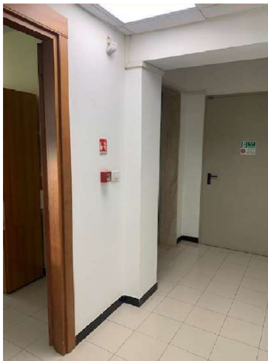
Zona uffici piano terra
