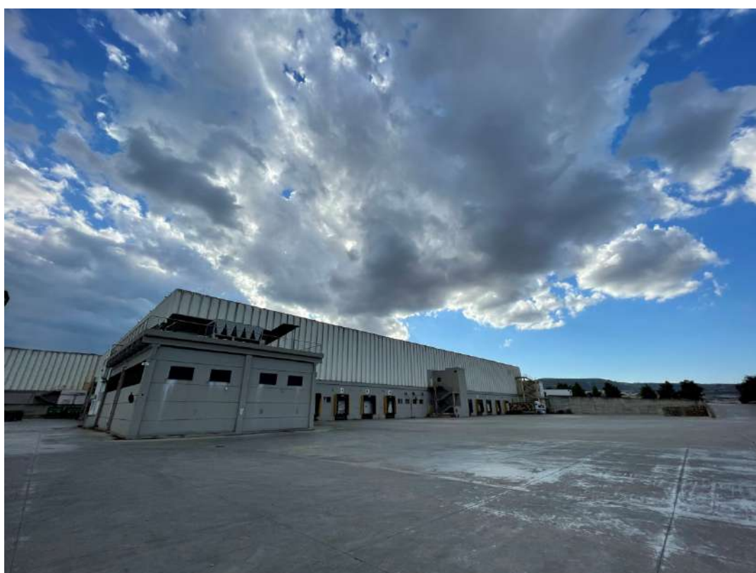
Vista esterna capannone lato Nord
