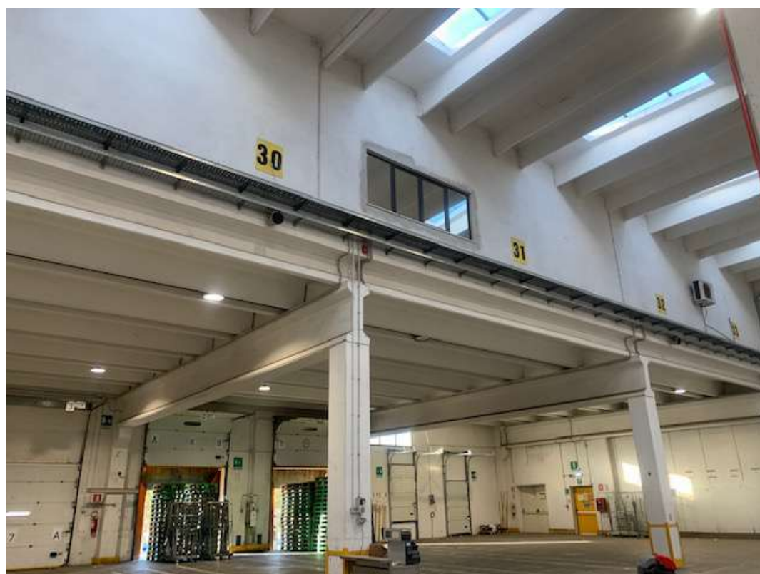
Zona carico e scarico Piano Terra
