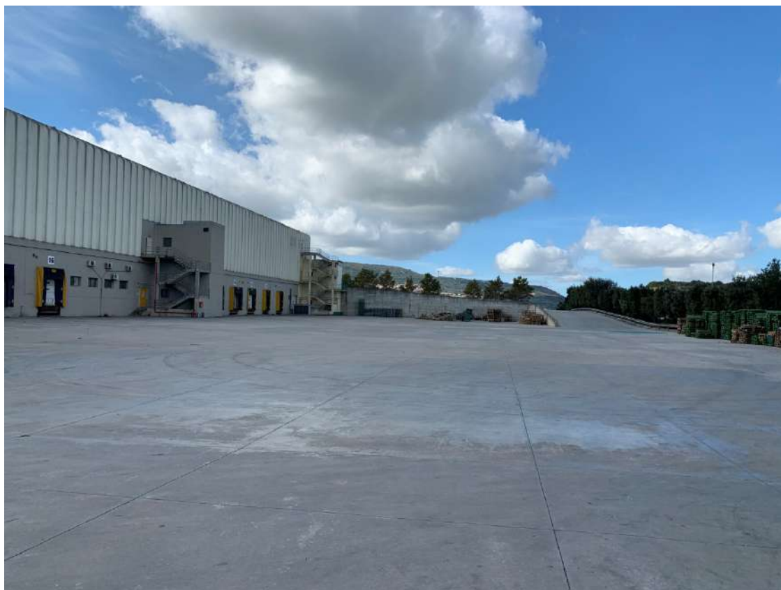
Rampa per accesso area carico e scarico piano S1- lato nord
