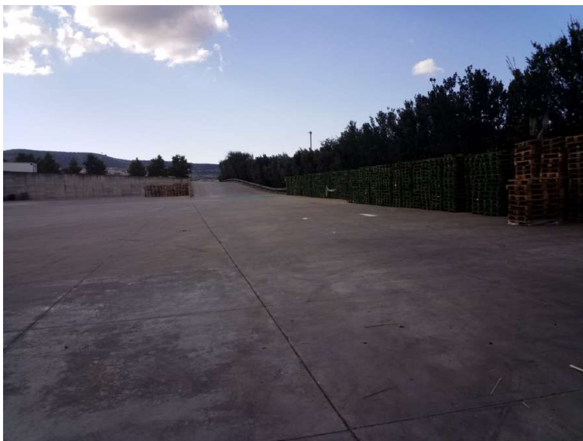
Rampa lato nord per accesso piano S1
