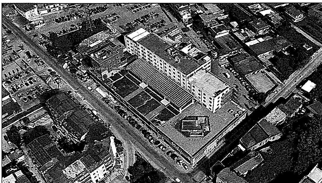
Figura 16. Vista del complesso immobiliare (prospetto ovest sulla SS 7 bis, via Appia).
