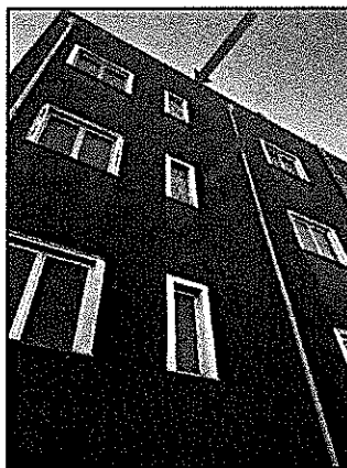
Figura 41. Prospetto nord della palazzina. Particolare chiusura finestre.
