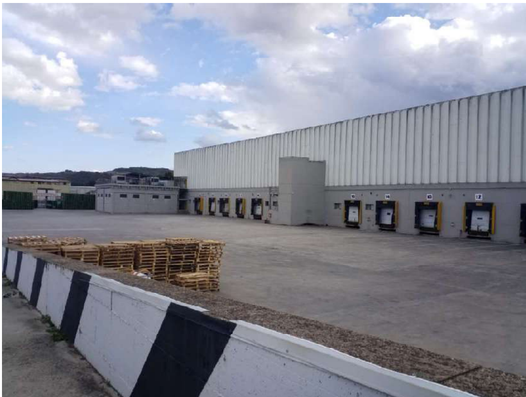
Vista esterna capannone lato Nord- zona carico e scarico S1
