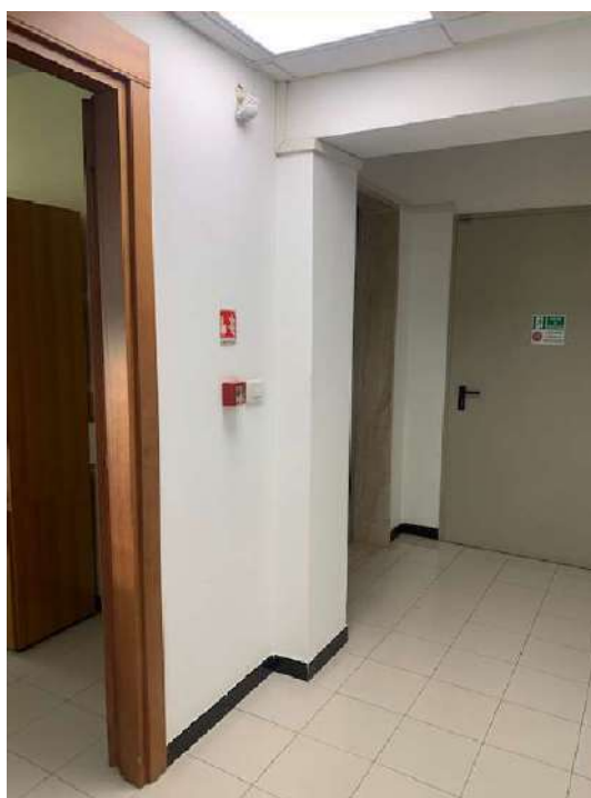
Zona uffici piano terra
