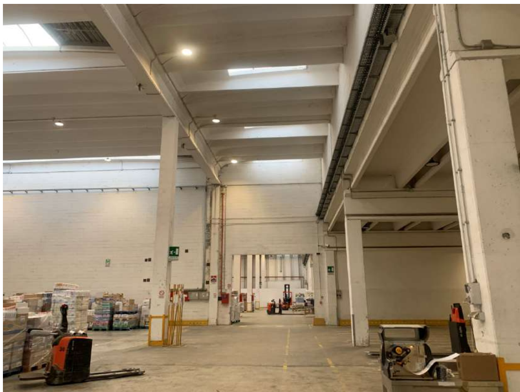
Parete separatoria del locale deposito piano terra in due comparti
