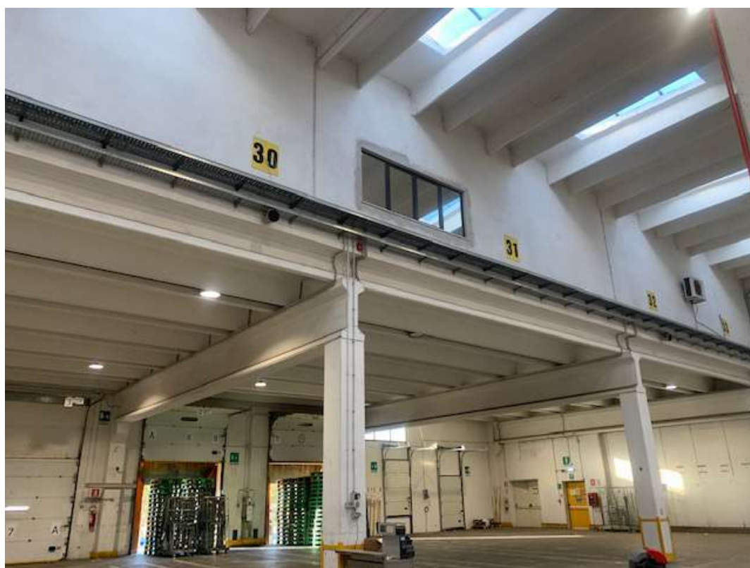
Zona carico e scarico Piano Terra
