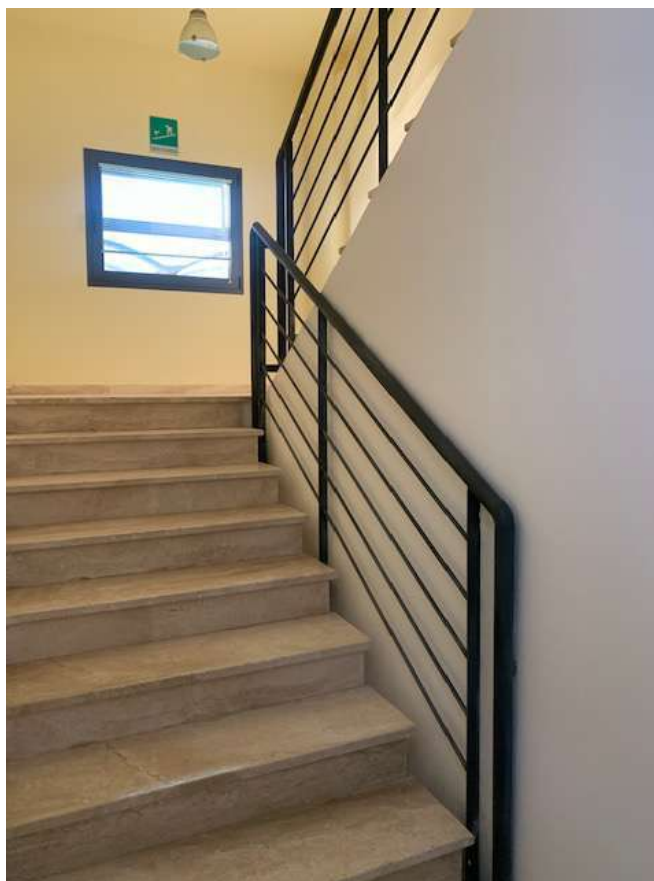
Vano scale dopo ingresso ascensore
