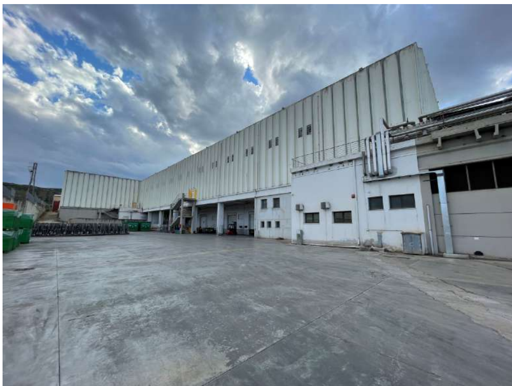
Vista esterna capannone lato Est
