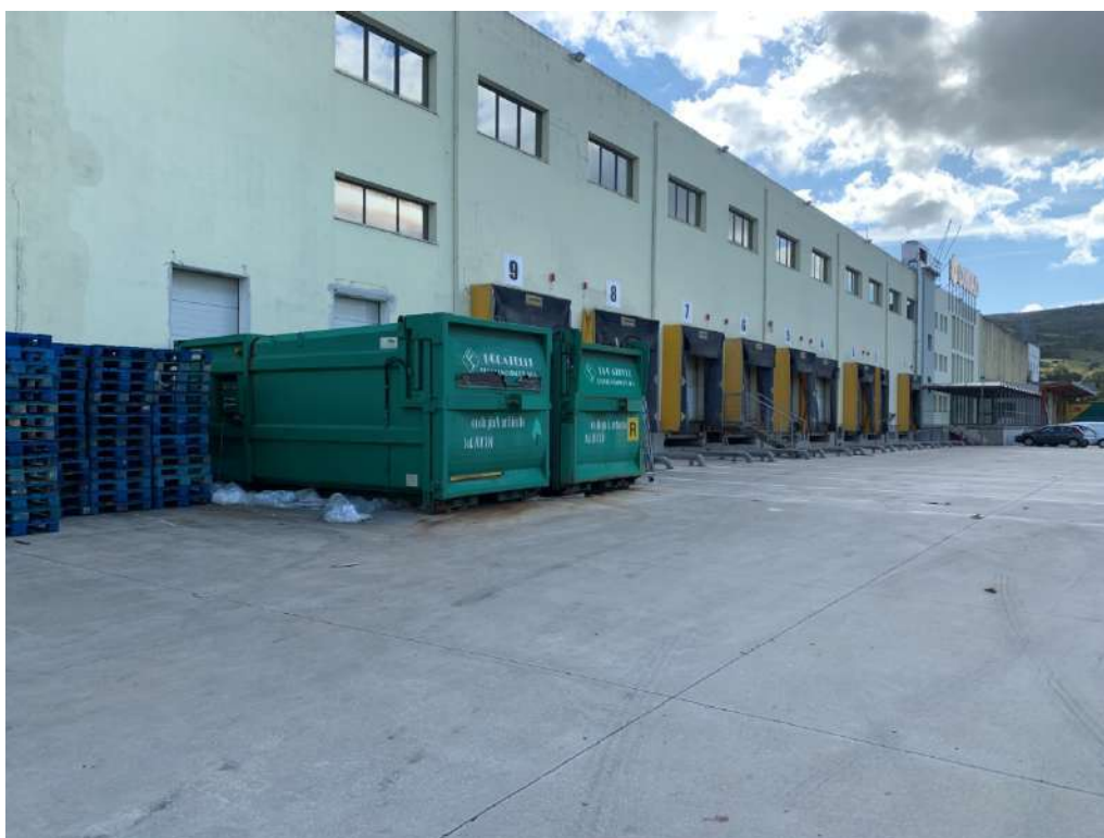
Capannone lato ovest accesso carico e scarico
