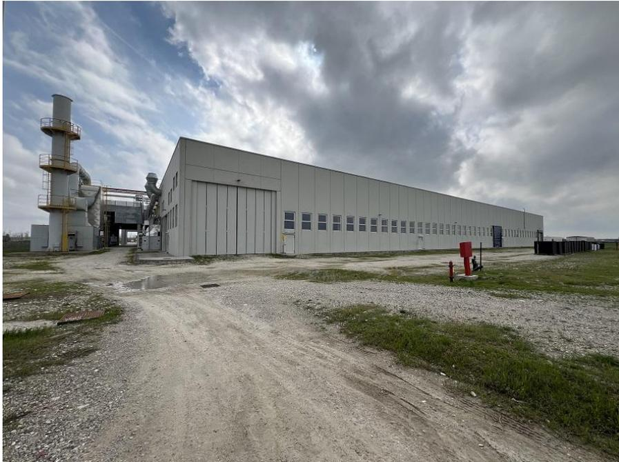
La porzione di testa in fondo sul alt ovest del lotto è anch'essa di recente edificazione, ed è composta da un ampio capannone di forma rettangolare con struttura prefabbricata in c.a. a due campate a travi e pilastri con copertura in copponi semicircolari tipo "shed" e finestre a nastro, avente una dimensione di circa mt. 120 x 50 x H 10,00. Le interrassi dei pilastri sono di circa mt. 10 x 25, con un'unica fila centrale.
