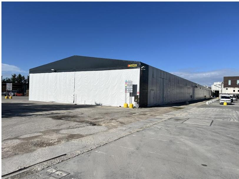
Trattasi della classica struttura in acciaio a tralicci incrociati, coperta da un telo in pvc poliestere facciate comprese, fornita dalla nota ed ormai azienda leader *Kopron* di Gorgonzola (Mi). La copertura è a due acque inclinate, e le dimensioni della struttura sono di circa mt. 106 x 21 con un'altezza media di circa mt. 6,20.
