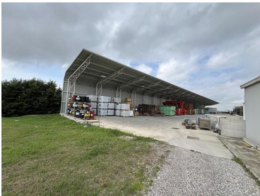
Struttura in ferro a sbalzo con profondità mt. 9,80 circa e con una lunghezza di circa mt. 120 x Hm 6,50, copertura tetto e parete schiena mediante pannelli a sandwich.
