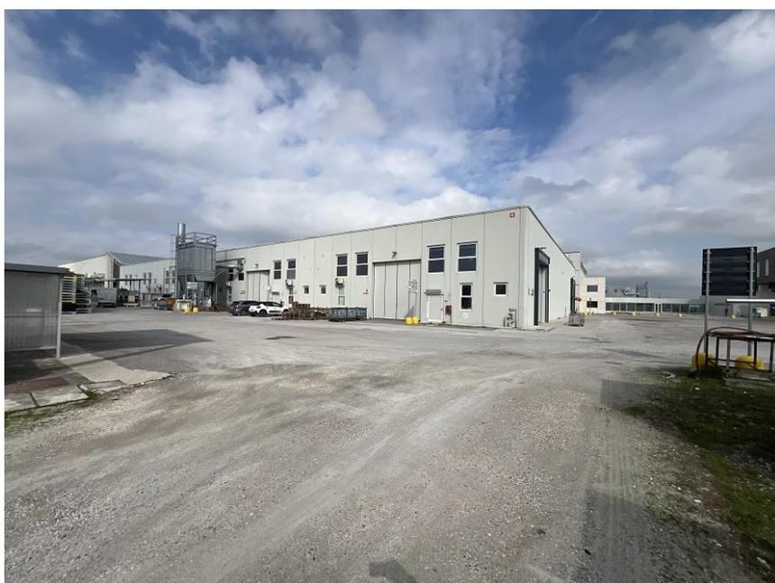
Trattasi di quattro recenti laboratori edificati con le medesime caratteristiche delle precedenti porzioni, a quattro campate. Tuttavia la struttura è più bassa con un'altezza interna di circa mt. 7,00.
