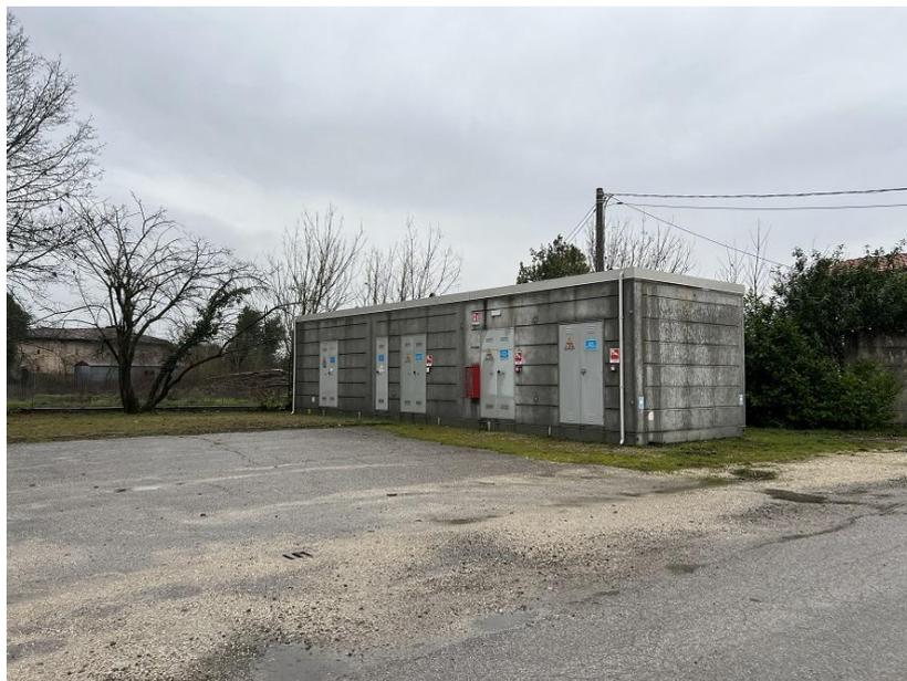
A fianco della suddetta palazzina uffici sul lato sud, è presente un'ampia cabina elettrica realizzata con struttura prefabbricata in cemento, utilizzata in parte da Enel spa ed in parte da Tecopress spa.
