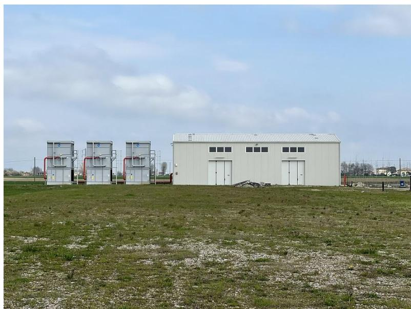
Si tratta di una struttura di forma rettangolare realizzata in ferro con pannellature di tamponamento e di copertura a sandwich. Viene utilizzata per il processo di trattamento delle acque, ed ha una dimensione di circa mtr. 25 x 11 x Hm 7,00. A fianco si sono tre torri evaporative.
