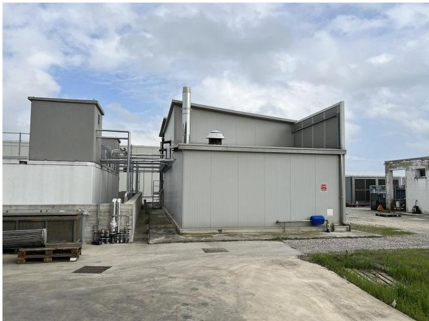
Sono composti da due corpi di fabbrica, di cui un primo più piccolo in muratura utilizzato come deposito attrezzi, ed un secondo più ampio per le caldaie ed altri locali per l'emulsione dell'acqua. A fianco ci sono 4 vasche di emulsione. Le superfici sono in seguito indicate.
