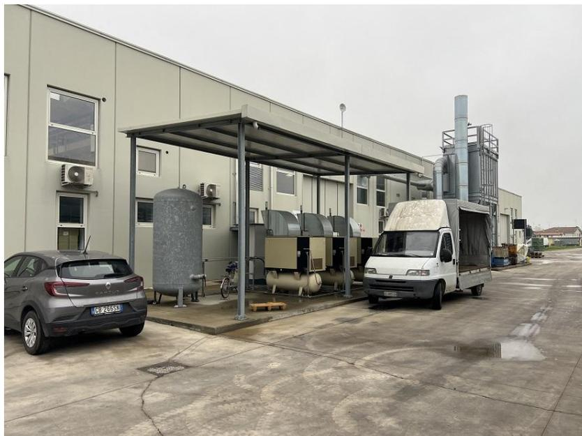
Su base di cemento ha una dimensione di circa mt. 9 x 5 x Hm mt.4,40, realizzata con travi in ferro e copertura a sandwich.
