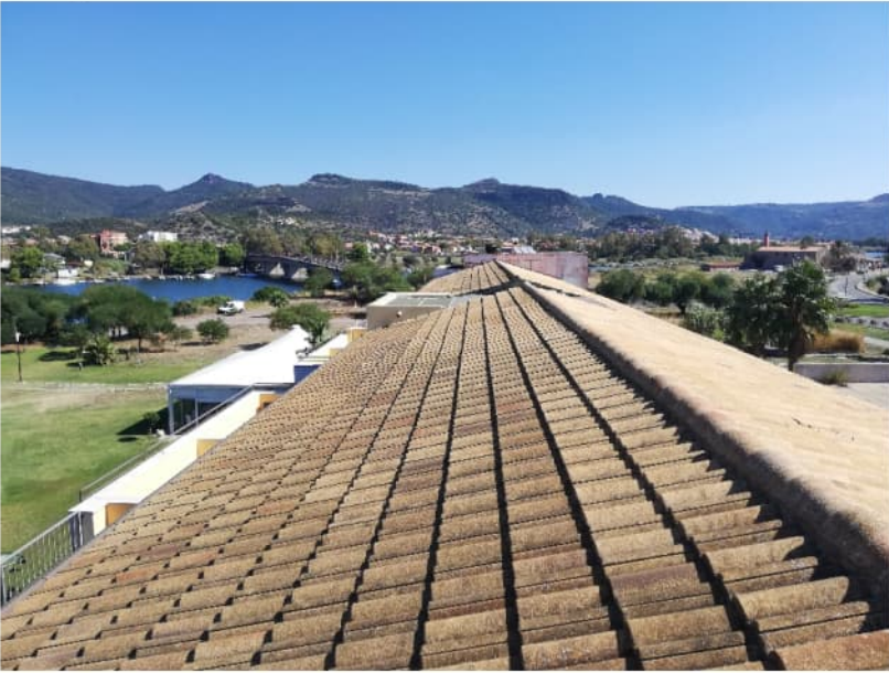
Foto 21) 22) Vista sulla copertura a tetto
