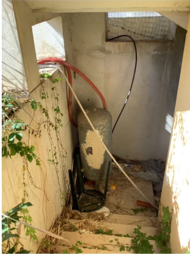
Foto 30) Ingresso al locale interrato lato Ovest
