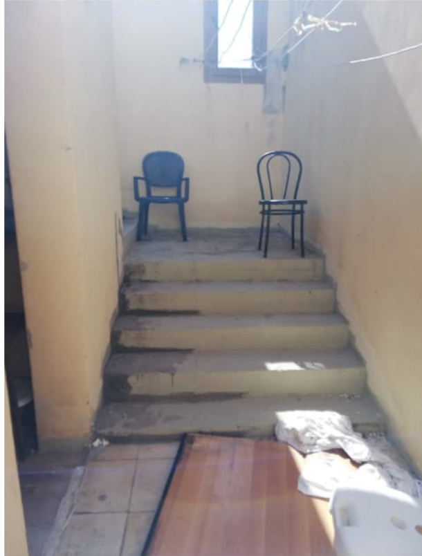
Foto 23) Rampa di scala per l'accesso alla piccola terrazza di copertura
