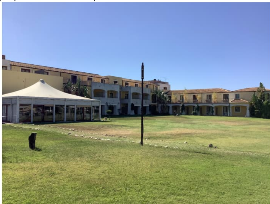
Foto 9) 10) Area a verde nella parte lato Nord verso il fiume.
