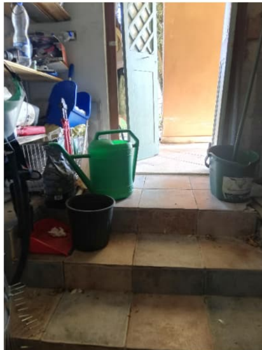
Foto 26) Scala accesso al piano interrato
