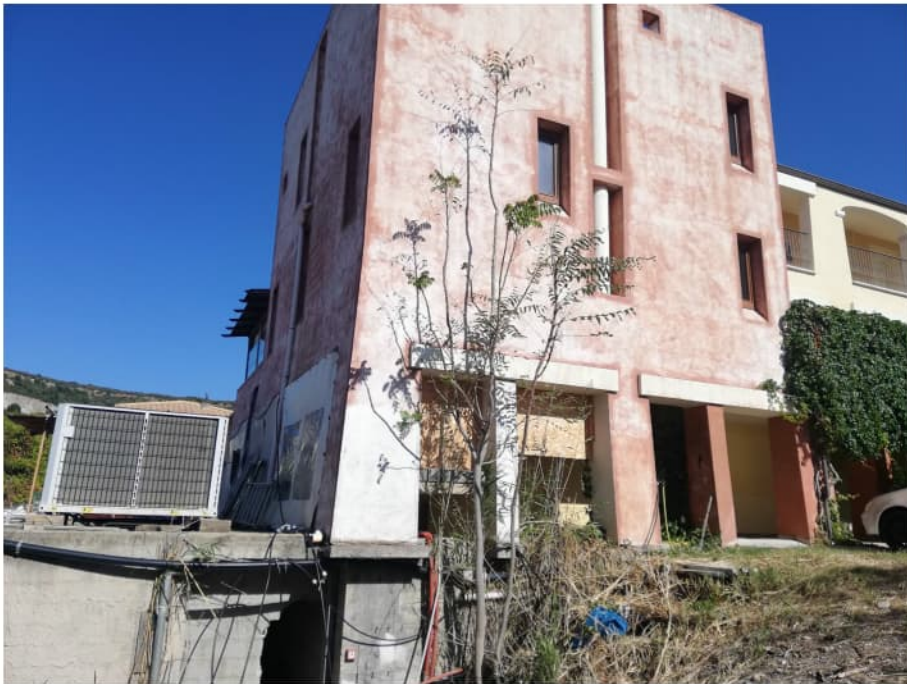
Foto 4) 5) 6) 7) 8) Lato Ovest dell'edificio (lato a confine con il canale di scolo)
