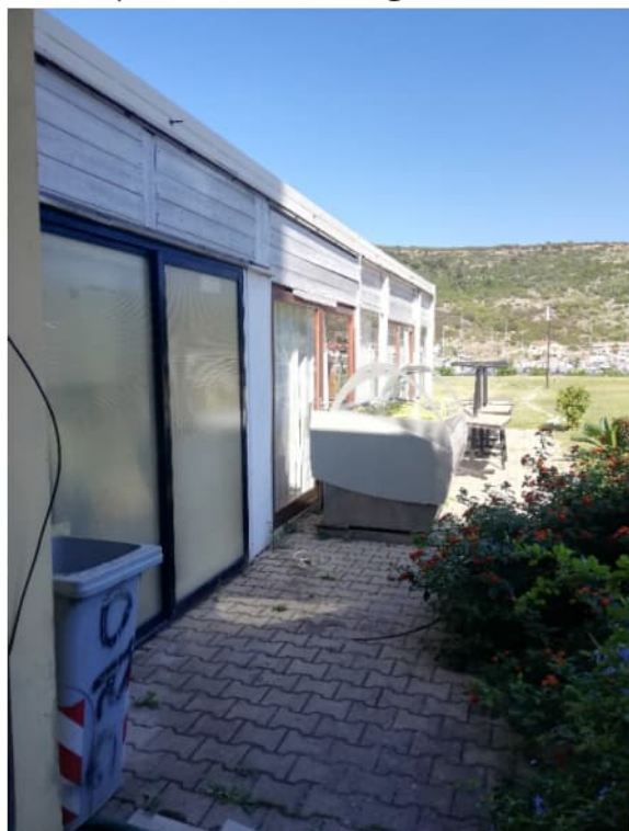
Foto 11) Parte esterna del gazebo
