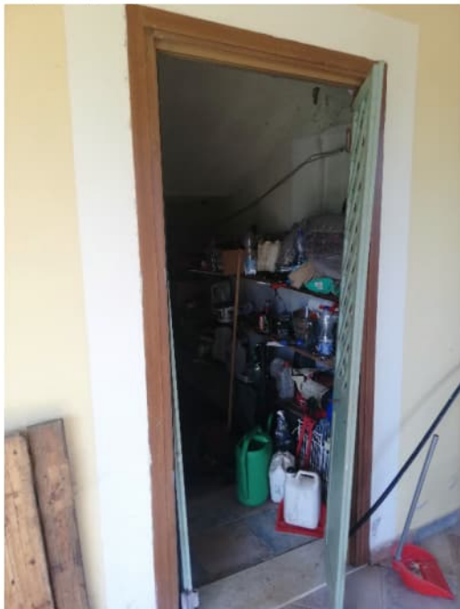
Foto da 25) a 29) Ingresso al locale interrato lato Est
