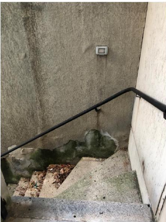
14 – Accesso alla porzione del seminterrato dal cortile minore
