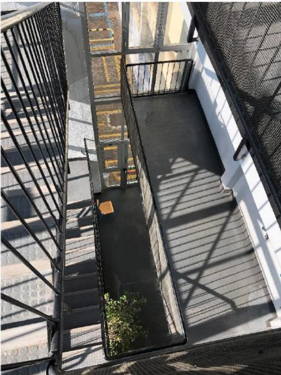
Foto 120 - SCALE DI ACCESSO PRINCIPALI
