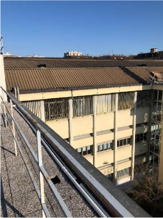
7 – Porzione di prospetto interno
