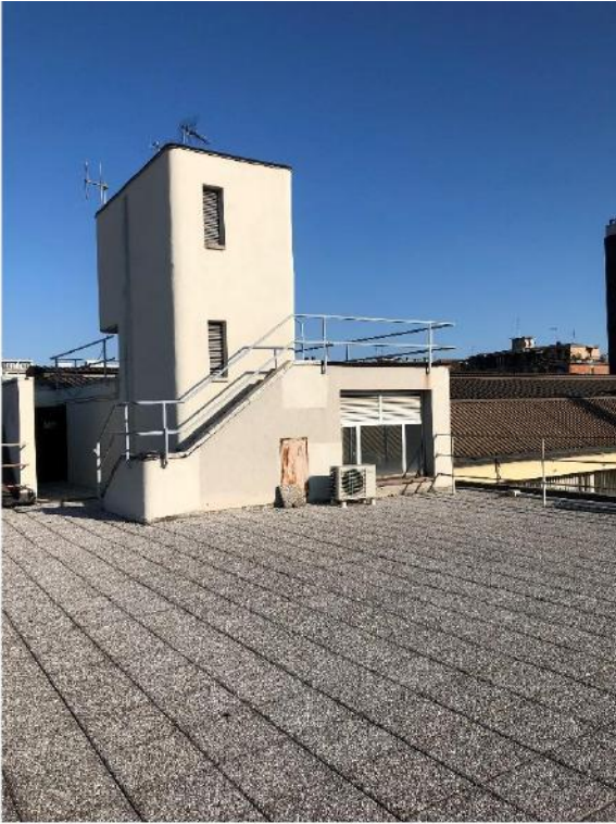
19 – Lastrico solare e vano tecnico ascensori
