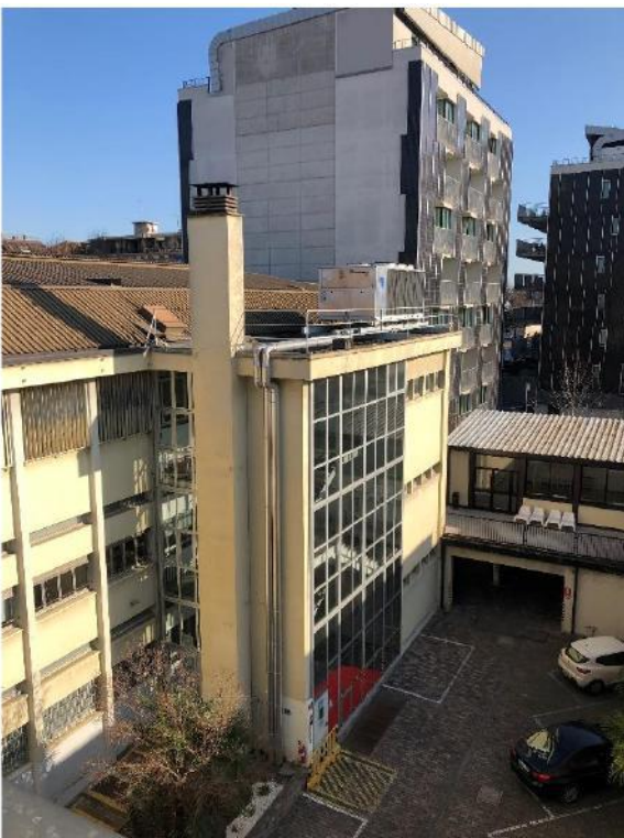
8 – Vano scale principale + autorimessa + locale con terrazzo
