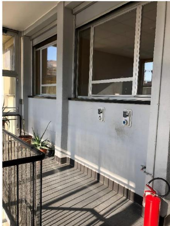
Foto 117 - SCALE DI ACCESSO PRINCIPALI
