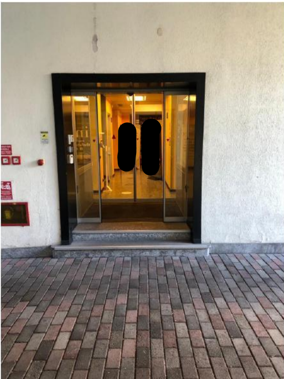
4 – Accesso all'edificio - portineria
