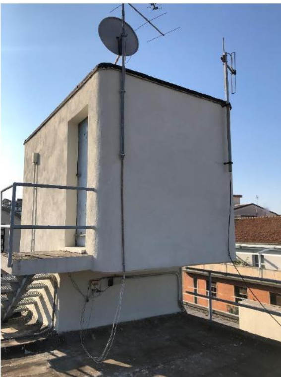
20 – Vano tecnico ascensori
