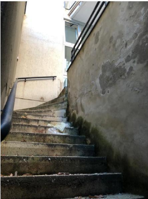
16- Accesso alla porzione del seminterrato dal cortile minore
