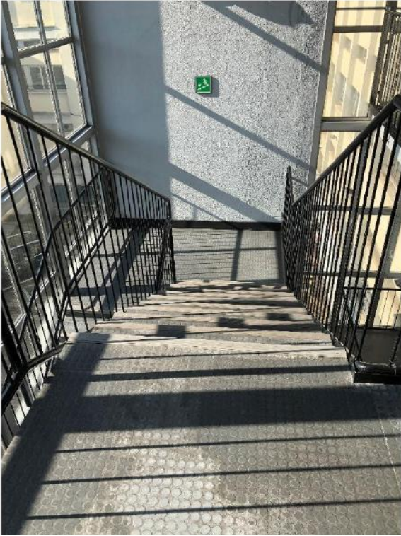
Foto 118 - SCALE DI ACCESSO PRINCIPALI
