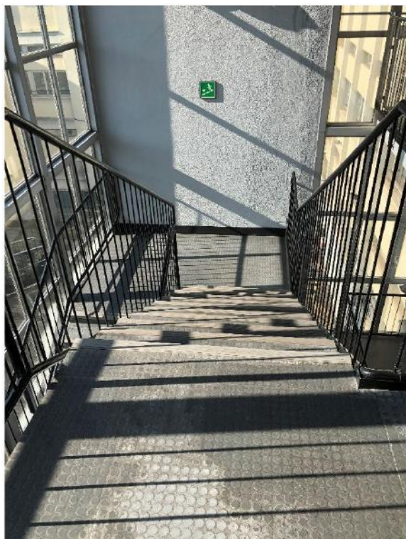
Foto 118 - SCALE DI ACCESSO PRINCIPALI
