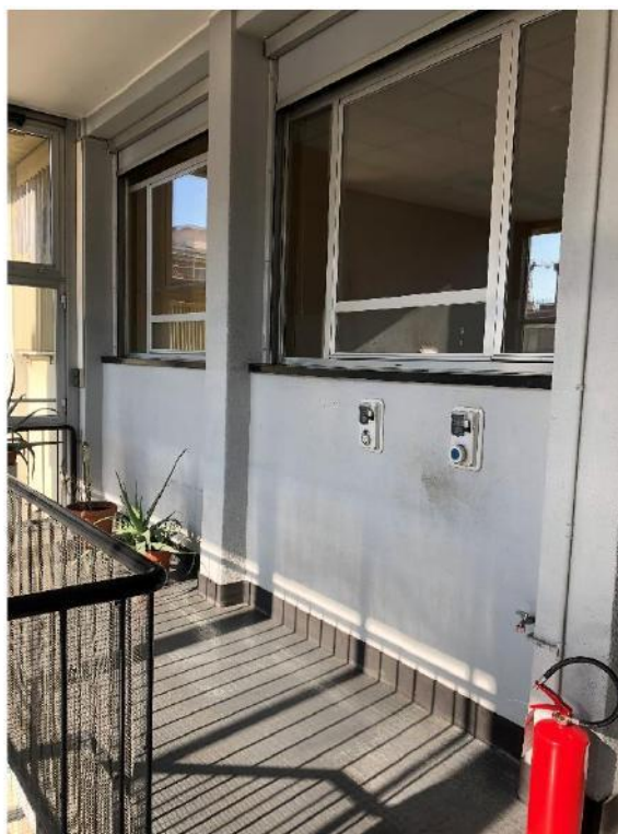
Foto 117 - SCALE DI ACCESSO PRINCIPALI
