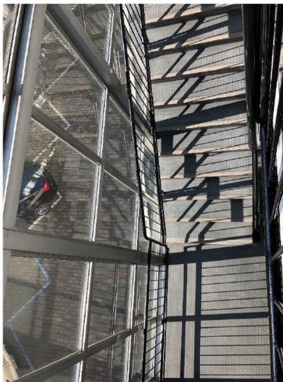
Foto 119 - SCALE DI ACCESSO PRINCIPALI
