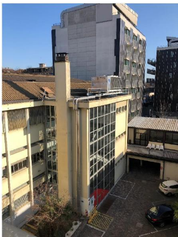
8 – Vano scale principale + autorimessa + locale con terrazzo
