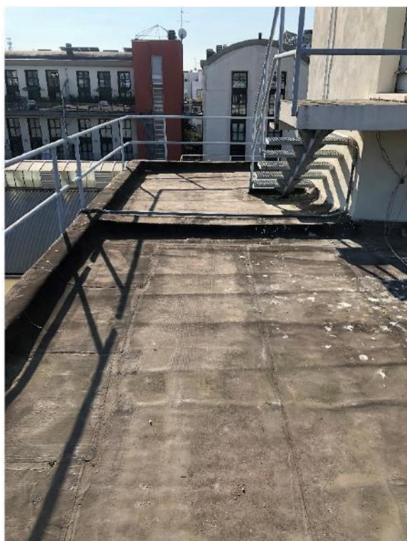
21 – Sbarco vano tecnico ascensori
