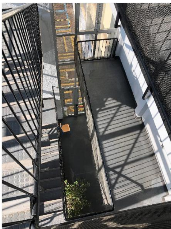
Foto 120 - SCALE DI ACCESSO PRINCIPALI
