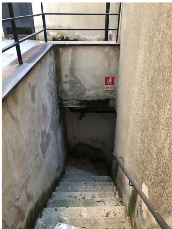
15– Accesso alla porzione del seminterrato dal cortile minore
