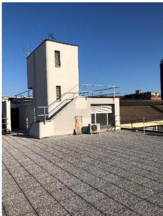
19 – Lastrico solare e vano tecnico ascensori
