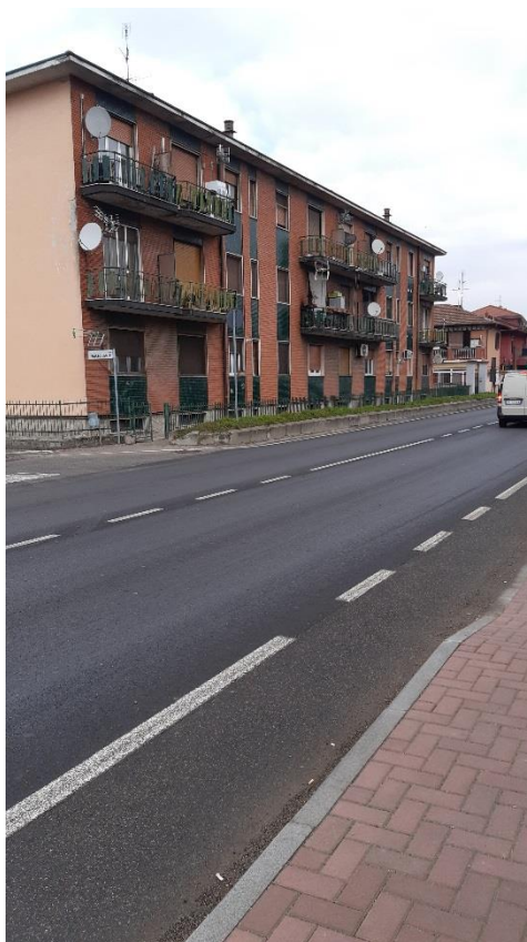
Via Cerca, 12 – fronte su strada
