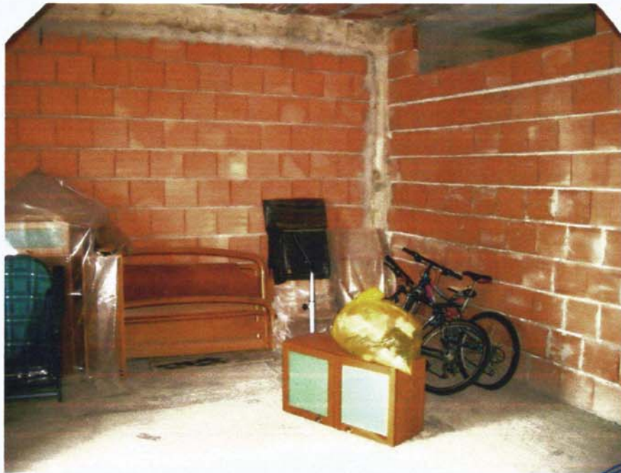
Foto A16: Piano primo: locale di ingresso
