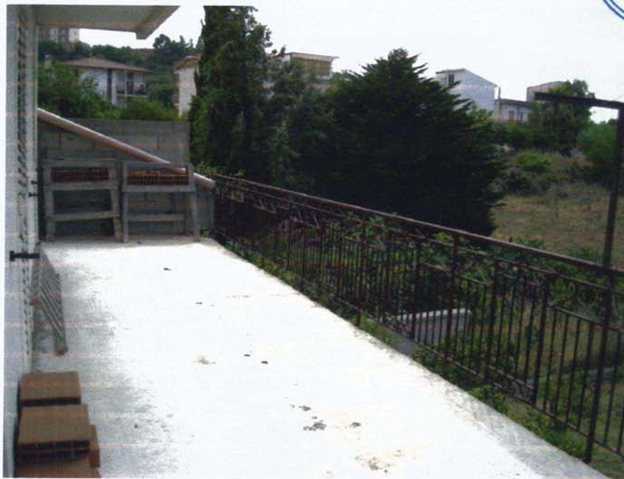
Foto A13: Piano primo: il terrazzino (lato Ovest)
