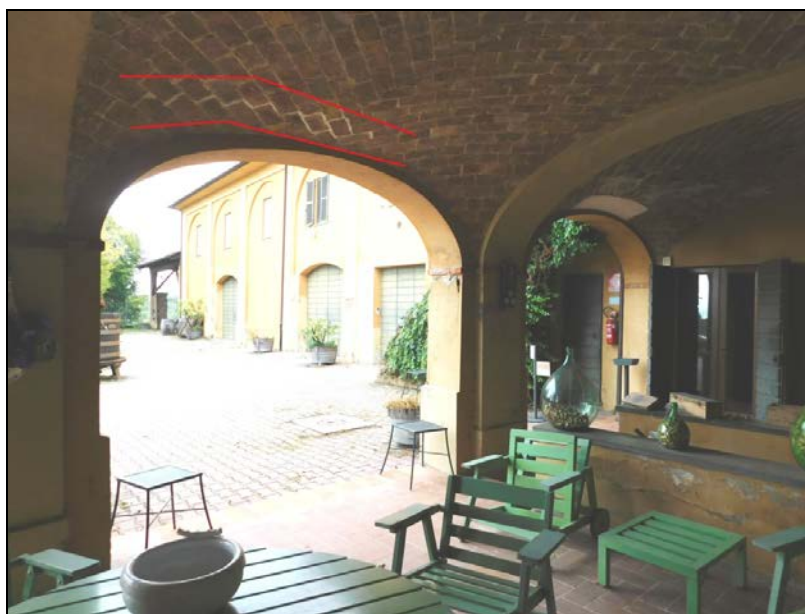
Cuciture strutturali della volta sottostante
