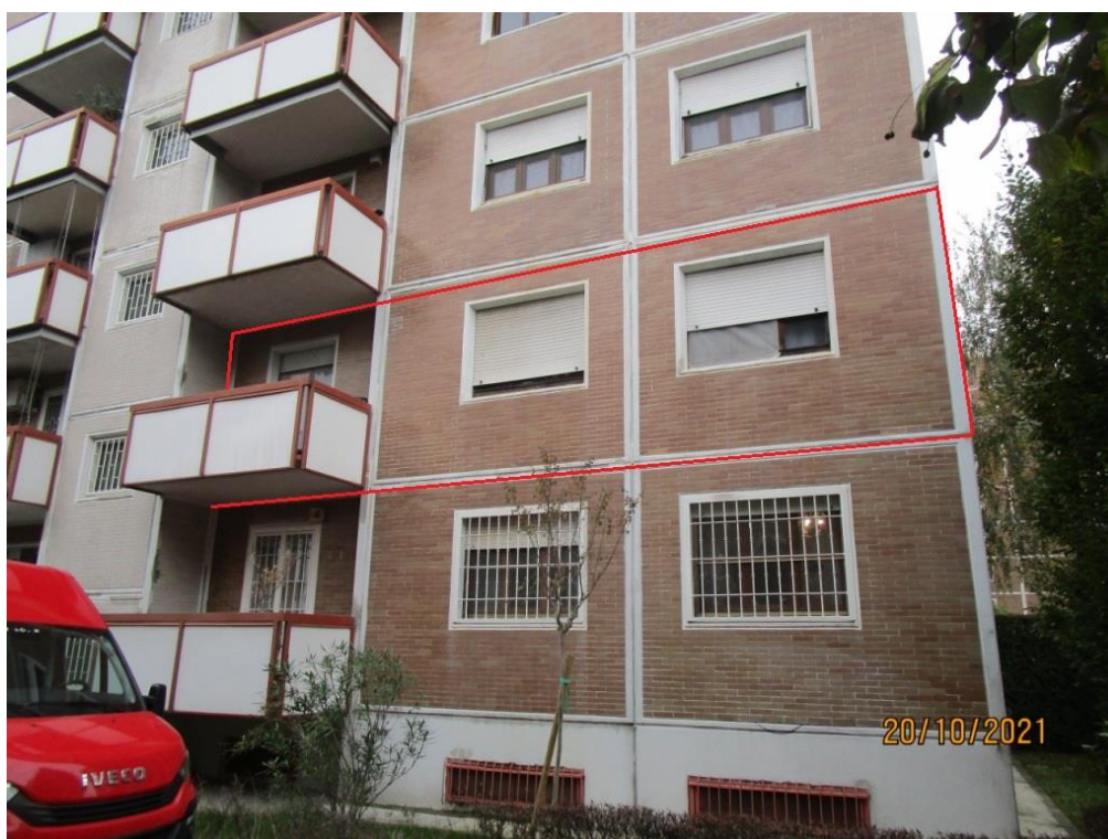
Foto 2 – Vista e inquadramento dell'unità immobiliare, da via V. E. Orlando
