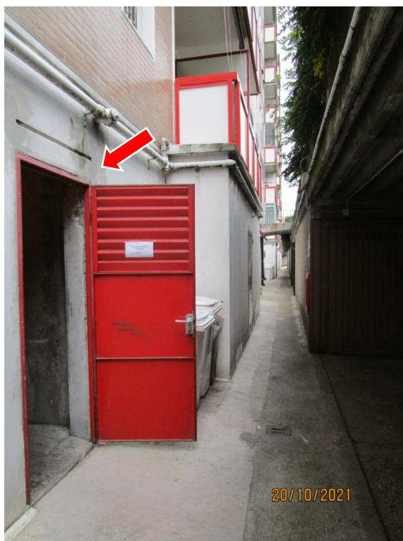
Foto 32 – Vista dal corsello autorimesse, dell'accesso alle cantine
