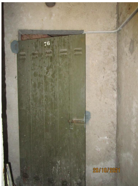
Foto 35 – Cantina di pertinenza (numero d'interno 76)
