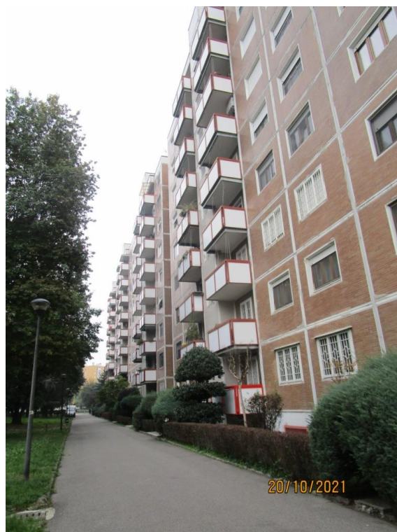
Foto 1 – Vista del complesso immobiliare di via Orlando
