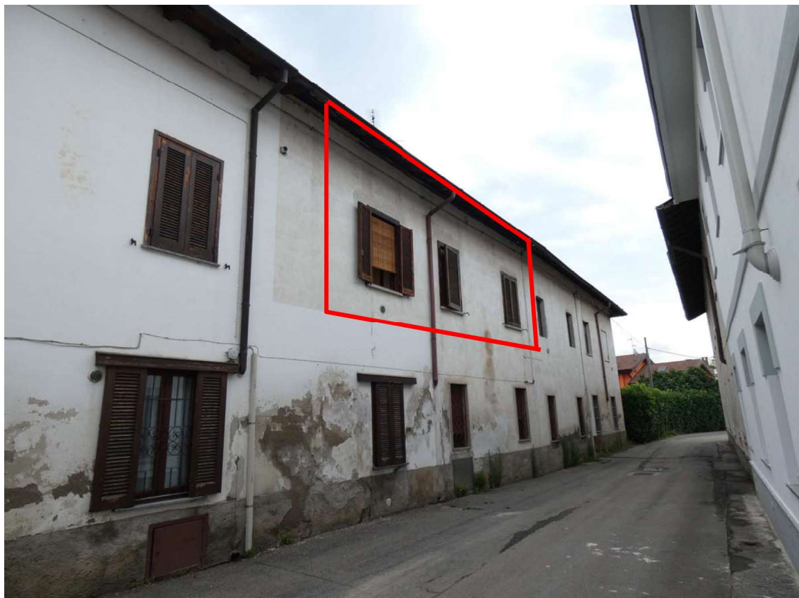
Foto 2. Prospetto su Via Monte verso dove affaccia l'immobile pignorato
