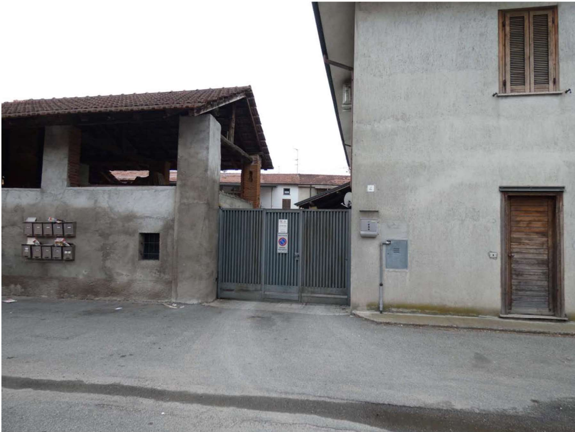
Foto 1. Cannello pedonale/carraio d'accesso al cortile in cui è ubicato l'immobile
