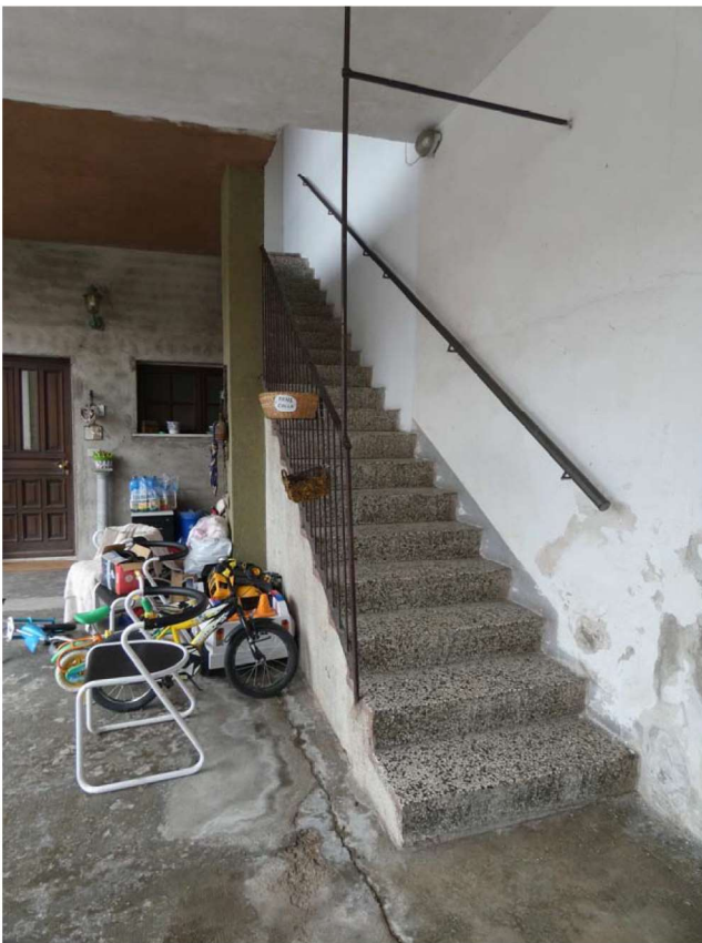
Foto 4. Scala d'accesso al piano primo
