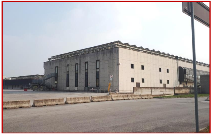
Figura 1 - Vista nord-ovest dell'immobile
