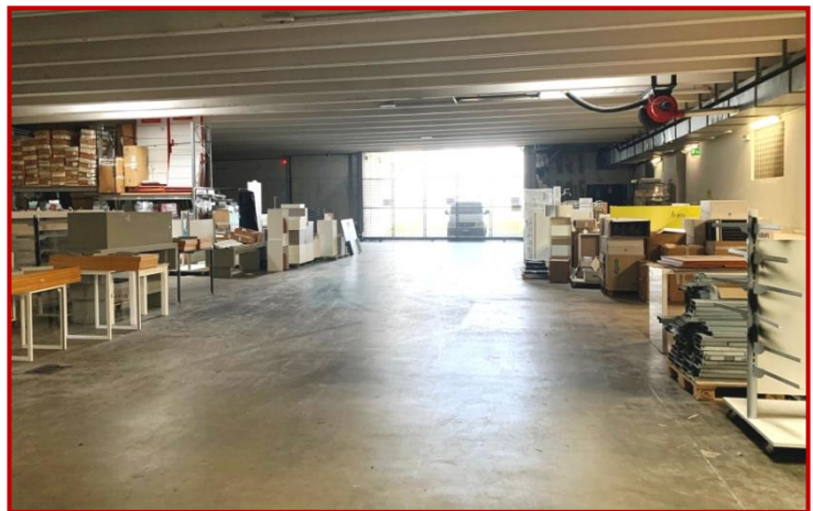
Figura 27 - Vista magazzini e arrivo rampa carrabile esterna
