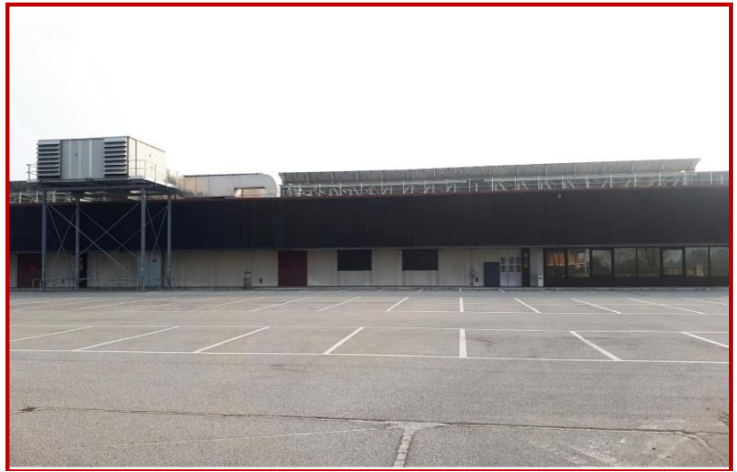
Figura 4 - Vista dell'immobile lato nord
