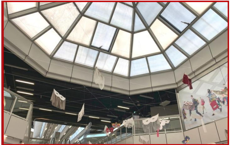
Figura 16 - Vista della copertura ottagonale della galleria
