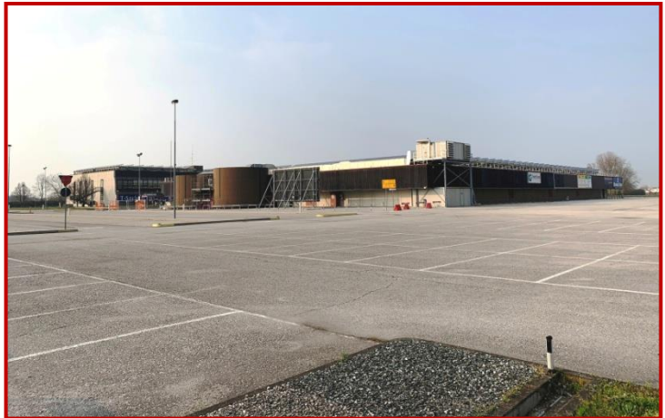
Figura 11 - Vista sud-est dell'immobile e del parcheggio
