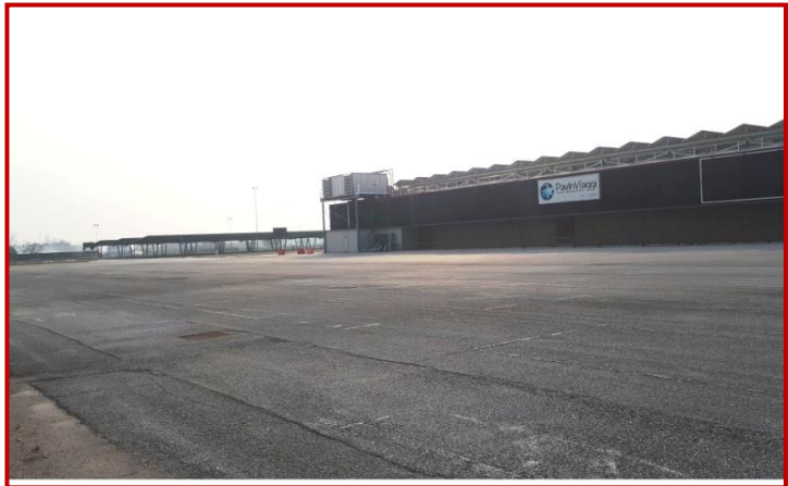
Figura 10 - Vista lato est, parcheggio e pannelli fotovoltaici
