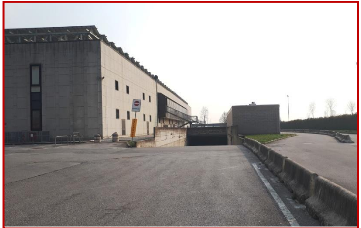
Figura 2 - Vista della rampa carrabile esterna
