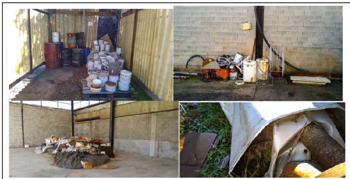
Fotografia 10: depositi vari in cui si vedono rottami ferrosi, RAE, latte fusti parti di tubi ammalorati con fuoriuscita del materiale coibentato sparsi in giro.
