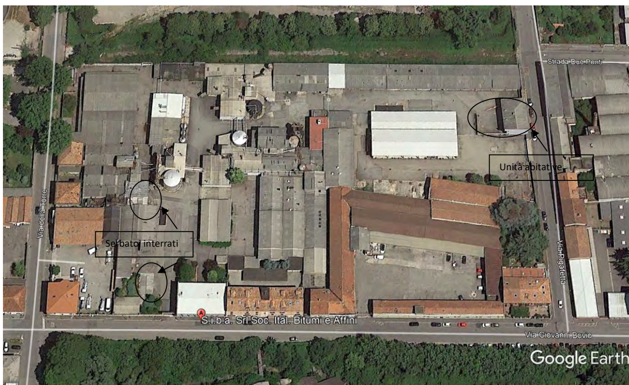
Img. 3 - Immagine satellitare del 26 settembre 2018 rappresentante l'azienda e il posizionamento dei serbatoi interrati e dell'unità abitativa.
