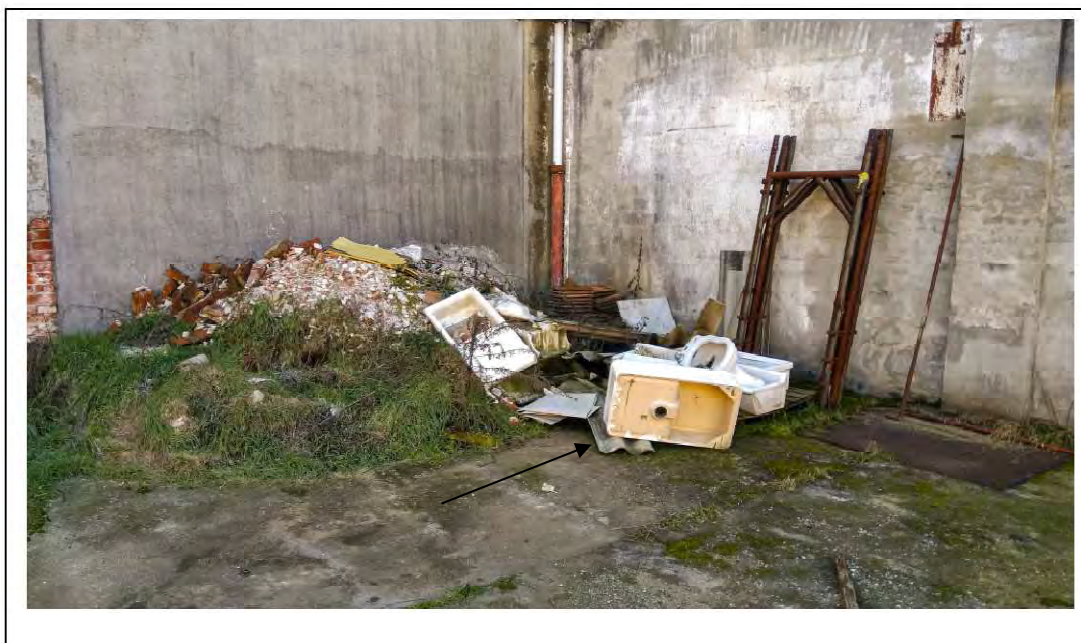
Fotografia 6: Deposito di macerie, in prossimità del magazzino ex XXXXXX con presenza di ipotetiche lastre in fibrocemento
