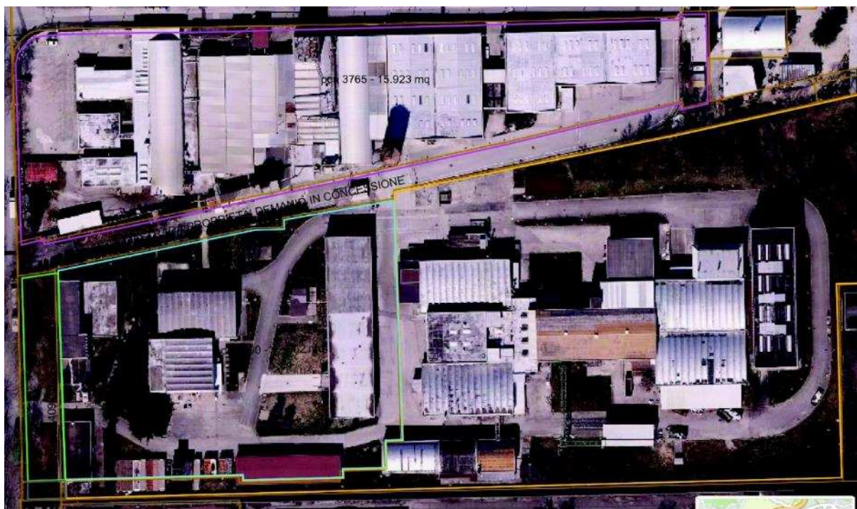
Foto 2: la presente riguarda i PERIMETRI AZZURRO GIALLO VERDE del comprensorio (parte sud)
