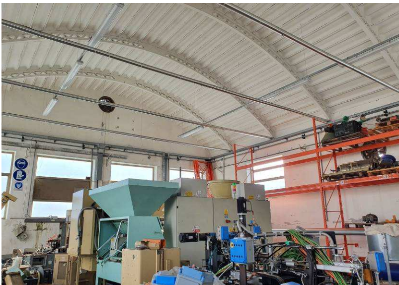
Foto 13: E10 interno magazzini
