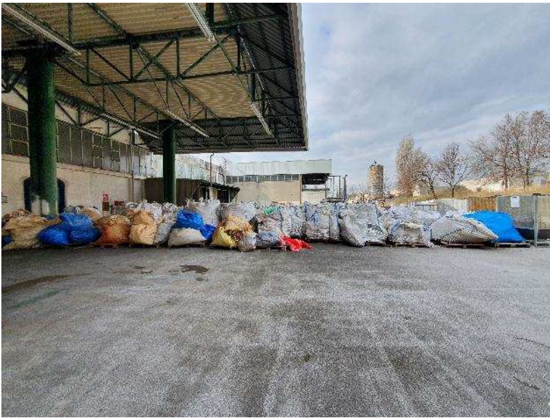
Foto 24: tettoie E9g E9f lato nord capannone 9
