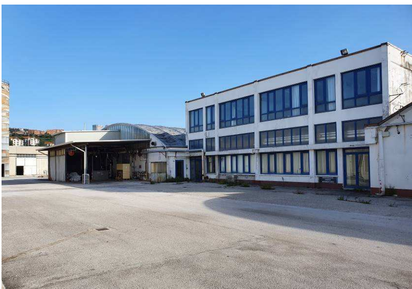
Foto 16: Edificio E9a al centro parte E9b ai lati (tetto a volta)
