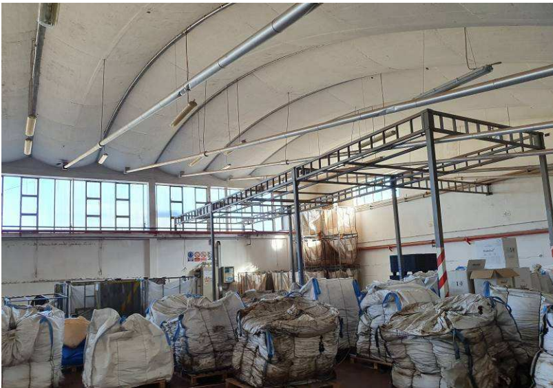
Foto 19: capannone E9b deposito ala nord
