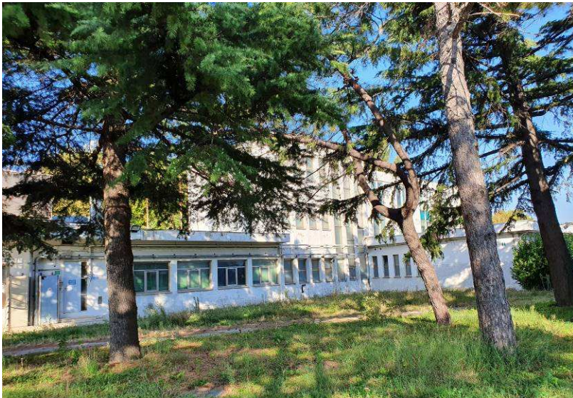
Foto 6: Edificio E1 esterno
