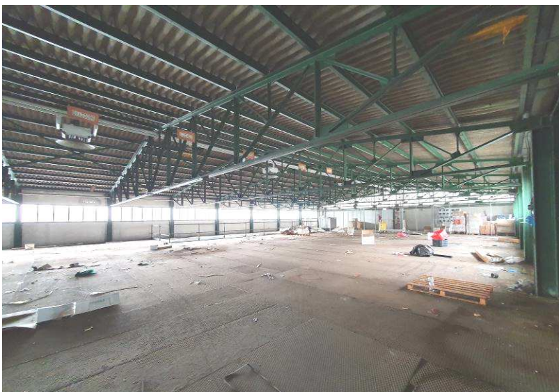
Foto 21: soppalco capannone E9c
