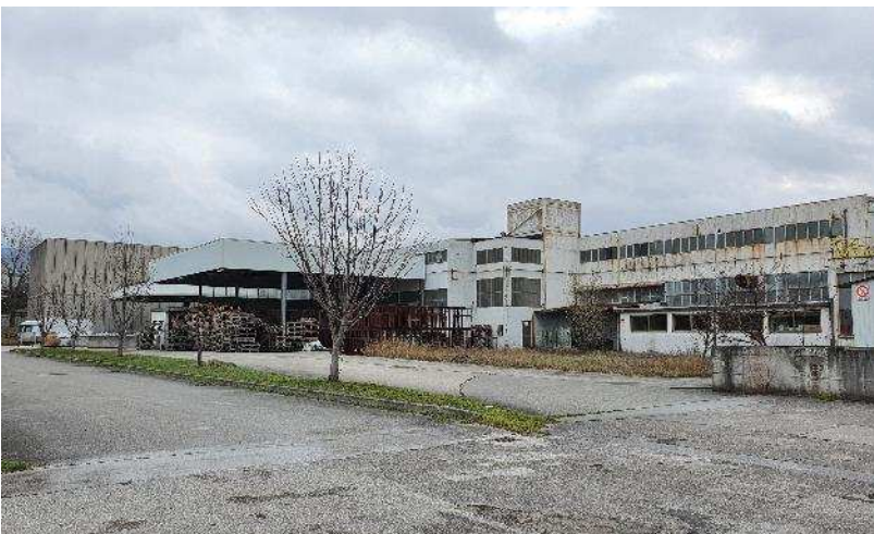
Foto 26: capannone 9 lato nord
