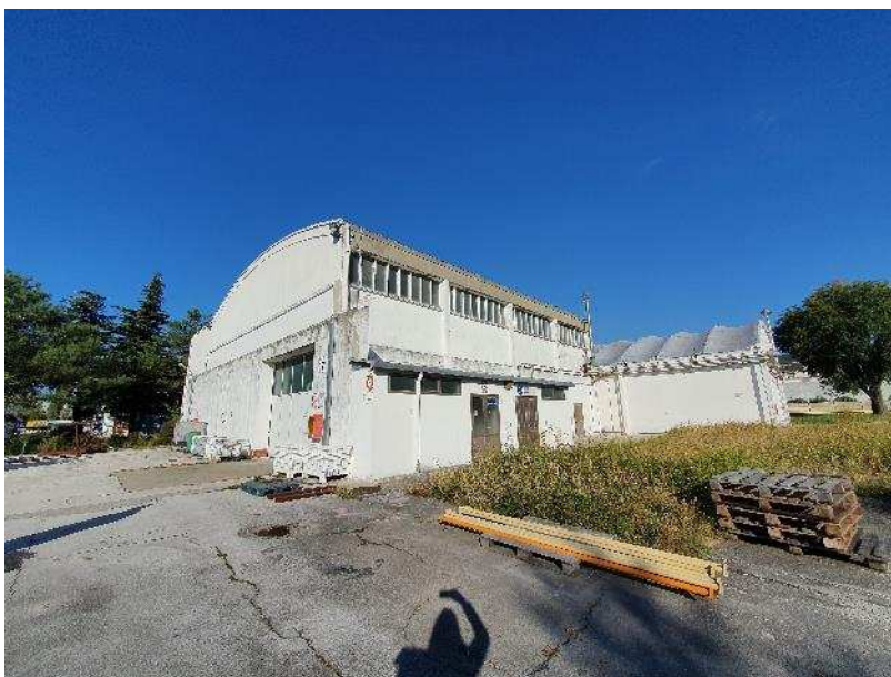
Foto 5: Edificio E3 esterno
