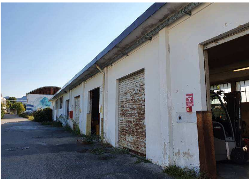
Foto 10: Esterno E5 magazzini
