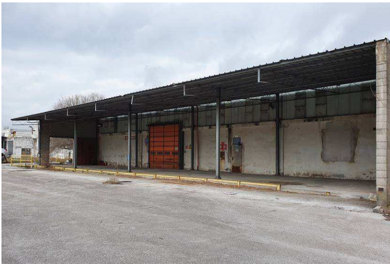
Foto 25: tettoia E9f lato sud lato sud capannone 9
