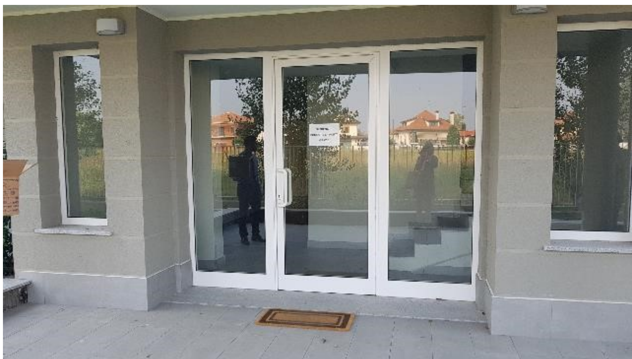
PORTONE INGRESSO PALAZZINA 2
