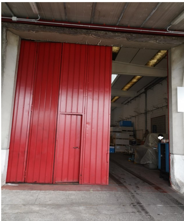
Fig. 7: Vista del portone d'accesso al capannone.
