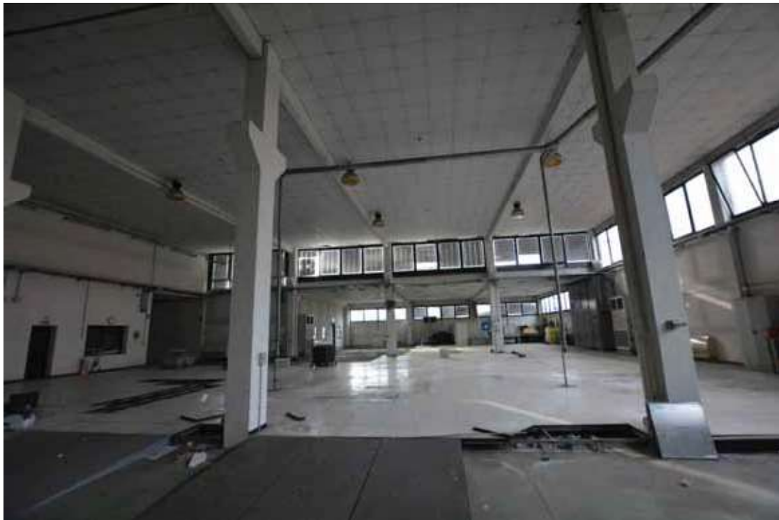
Foto 11 - U.i. "A." Capannone lato Nord
