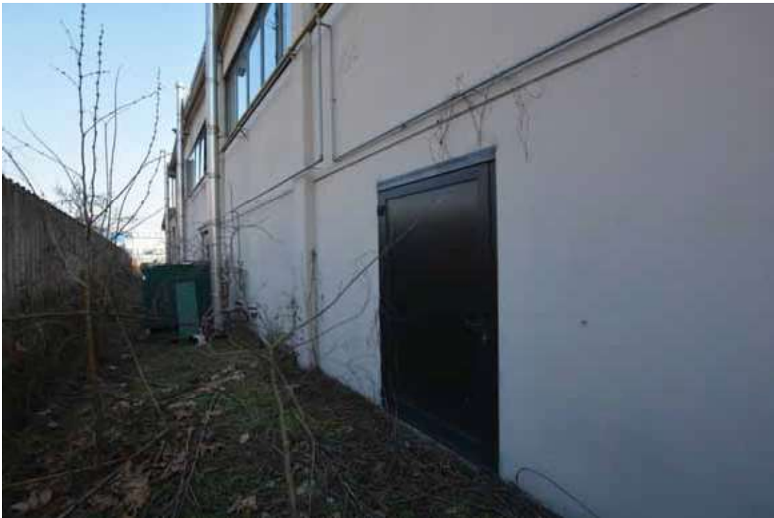
Foto 9 - U.i. "A." Capannone lato Ovest
