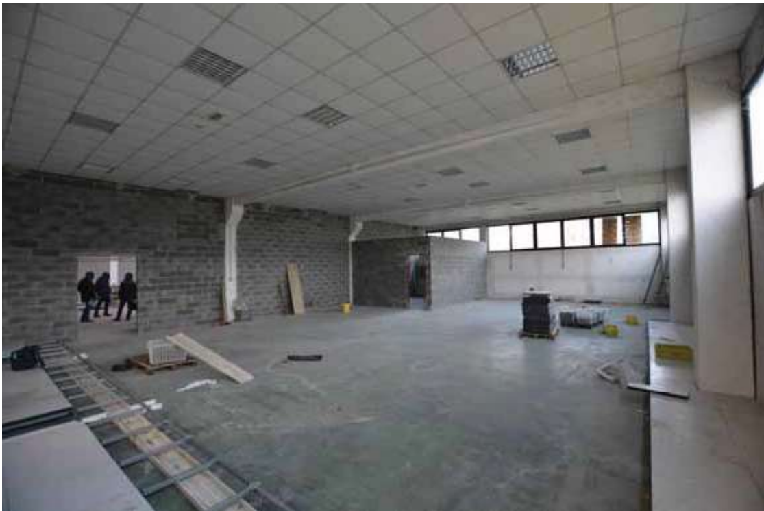
Foto 17 - U.i. "A." Vano 2 del Capannone a piano terra
