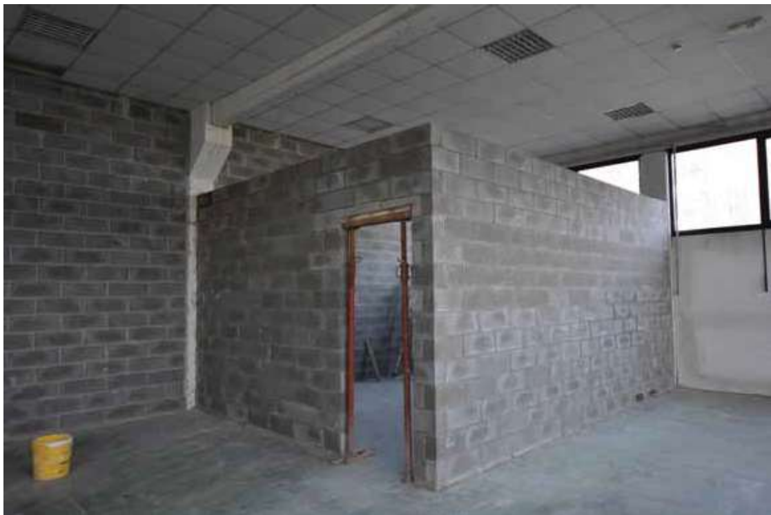
Foto 19 - U.i. "A." Vano 3 del Capannone a piano terra
