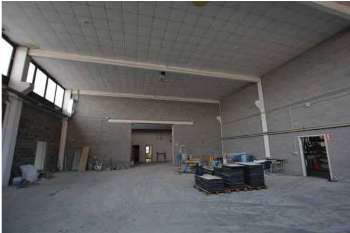
Foto 15 - U.i. "A." Vano 1 del Capannone a piano terra
