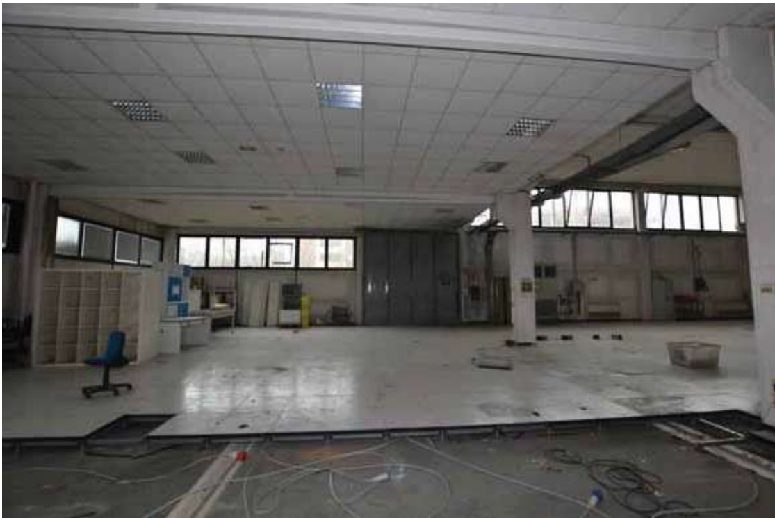
Foto 13 - U.i. "A." Vano 1 del Capannone a piano terra
