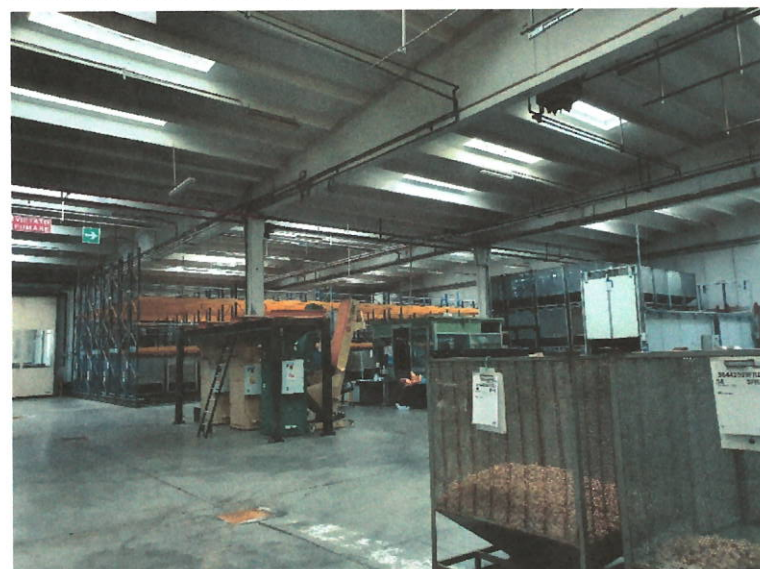
Foto 18: capannone immagazzinamento – corpo 5
