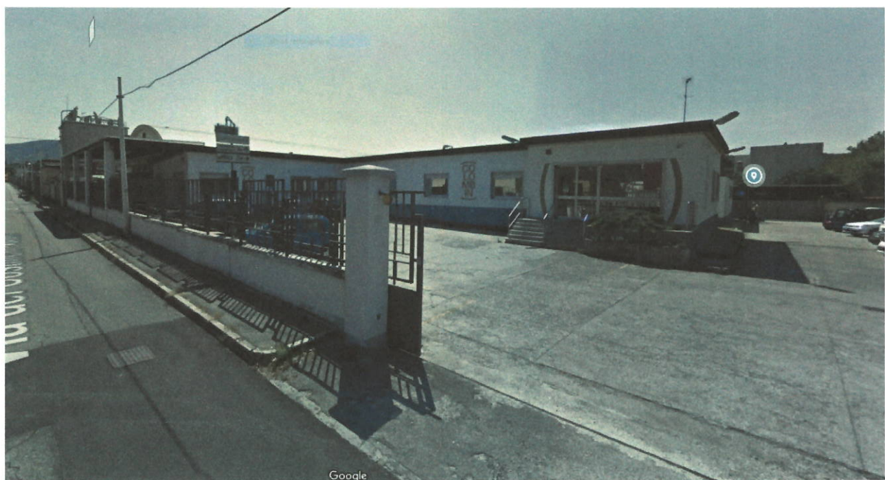
Foto 4: ingresso allo stabilimento (parte Uffici - corpo 1a)
