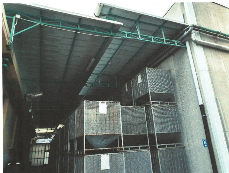
Foto 17: tettoia di collegamento corpi 4 -5 – corpo 4 a
