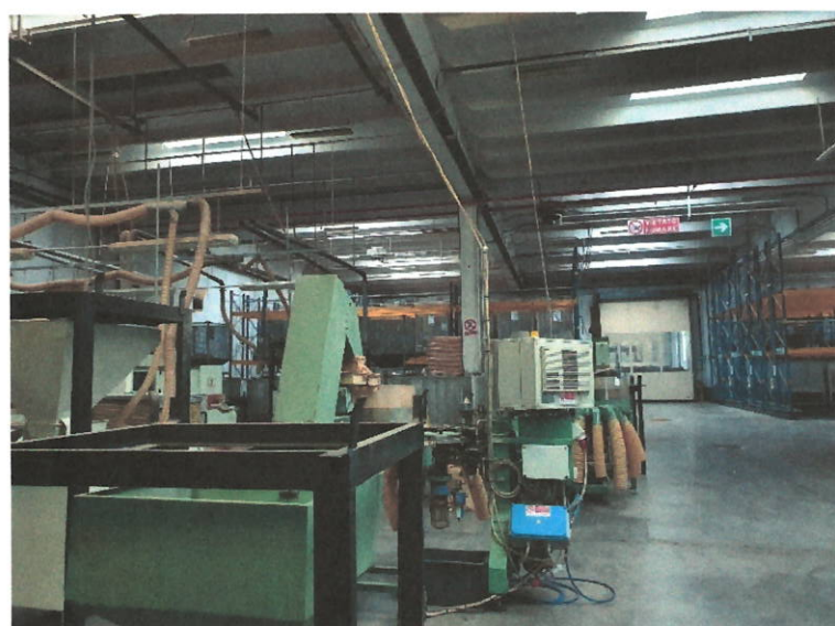
Foto 19: capannone immagazzinamento – corpo 5
