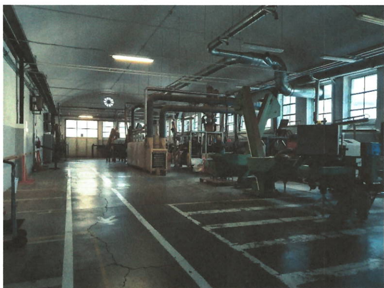
Foto 7: edificio formatura – forno – corpo 1
