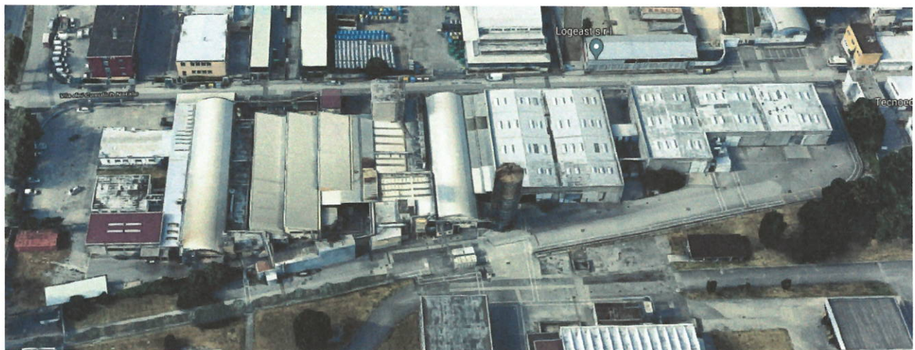
Foto 3: vista aerea del comprensorio pcn 3765 SMM inf.
