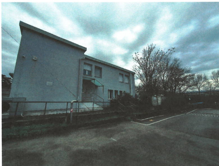
Foto 23: edificio foresteria esterno vista dal piazzale interno – corpo 7
