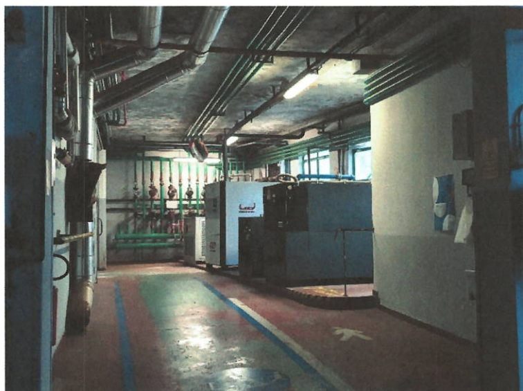
Foto 10: collegamento corpo 1 e 2 - impianto XXX
