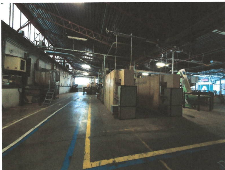
Foto 11: capannone lavorazione – corpo 2
