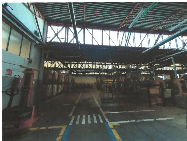
Foto 12: capannone lavorazione – corpo 2 vista da lato opposto
