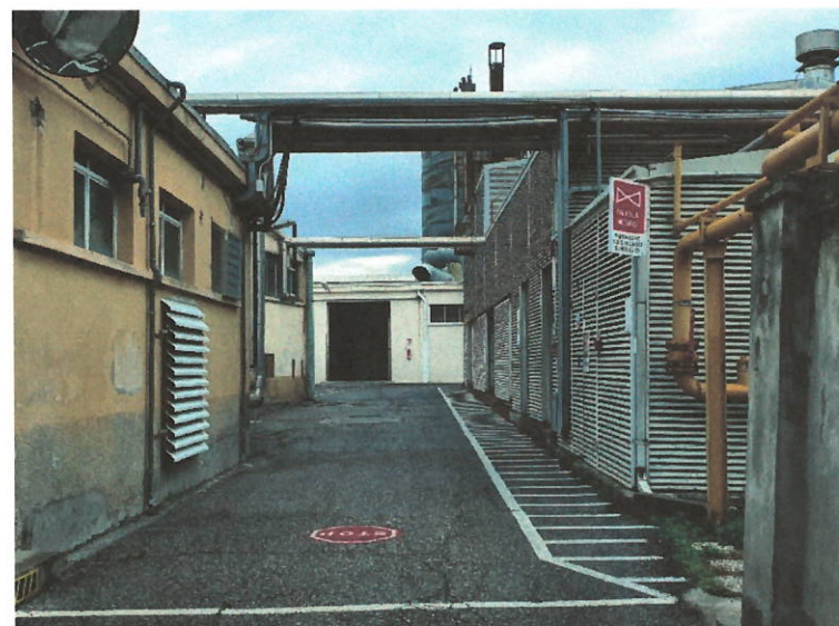
Foto 27: a destra esterno edificio 2, a sinistra centrale termica
