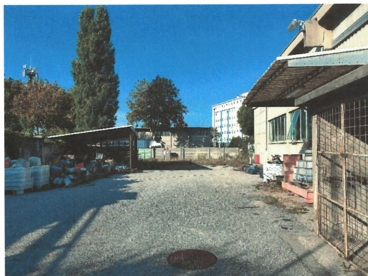
Foto 27: esterno officina corpo 1 c e tettoia 1 g (a sinistra) e 1 f (a destra)
