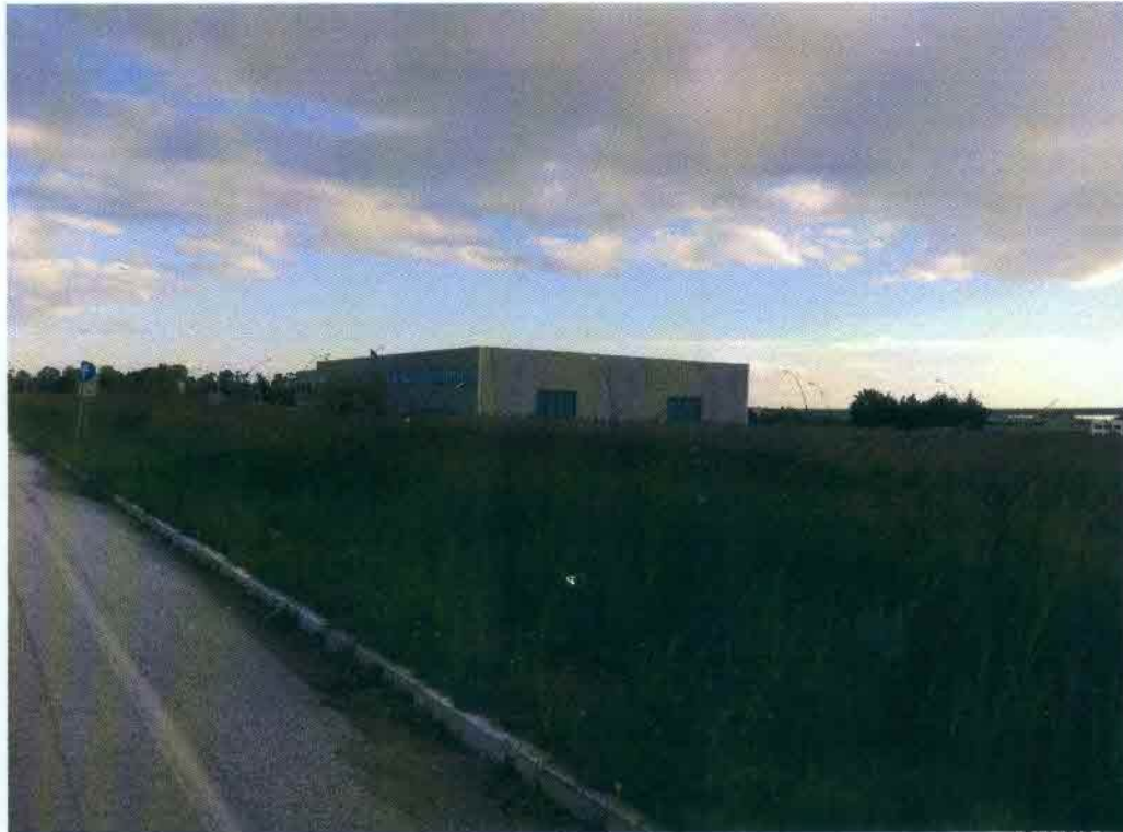
Foto 3: Vista immobile lato sud ed ovest
