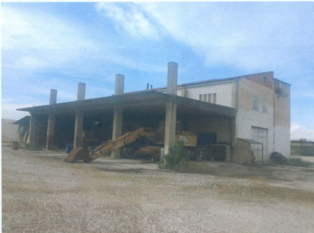
Palazzina "A" lato portico
