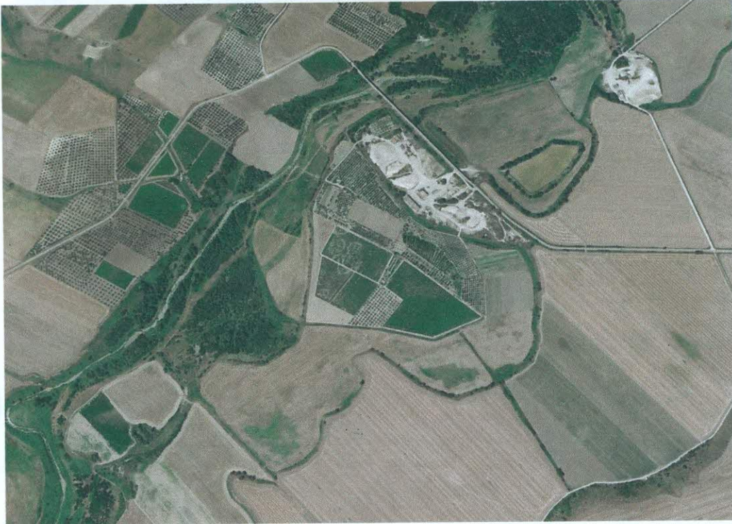
Foto Aerea della zona
