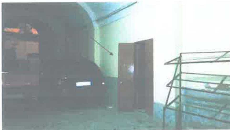
Foto n. 5 Ingresso dall'androne al negozio (sub 32)
