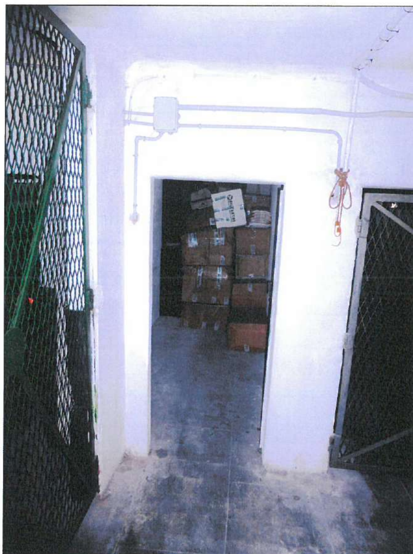
PORTA DI ACCESSO ALLA CANTINA
