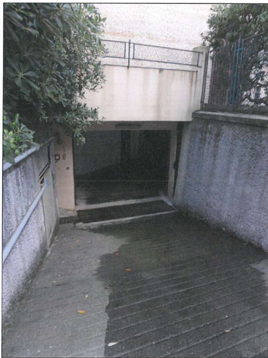
RAMPA DI ACCESSO AI FONDI
