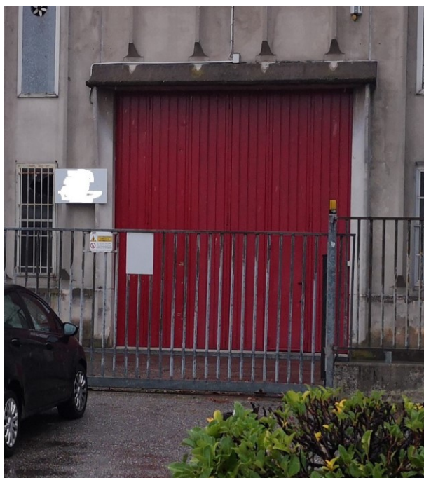
Fig. 15: Vista del portone d'accesso al capannone.
