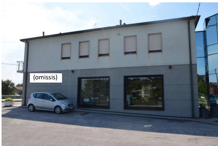
Vista avancorpo negozio lato est
