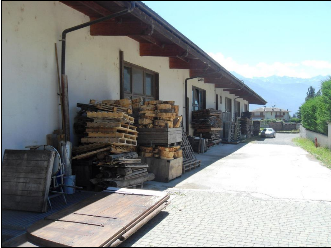
Facciata nord-ovest del fabbricato Fg. 32 mapp. 904-906-909 (vista da nord-est)
