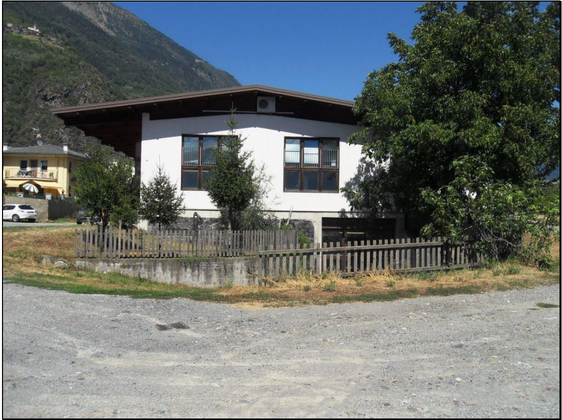
Facciata sud-ovest del fabbricato Fig. 32 mapp. 904-906-909 (vista da sud-ovest)
