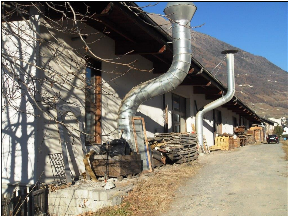
Facciata sud-est del fabbricato Fg. 32 mapp. 904-906-909 (vista da sud-ovest)
