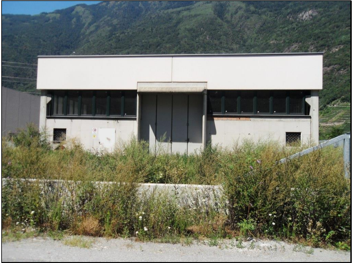
Facciata sud-est del fabbricato Fig. 42 mapp. 1191 sub. 1 (vista da sud-est)
