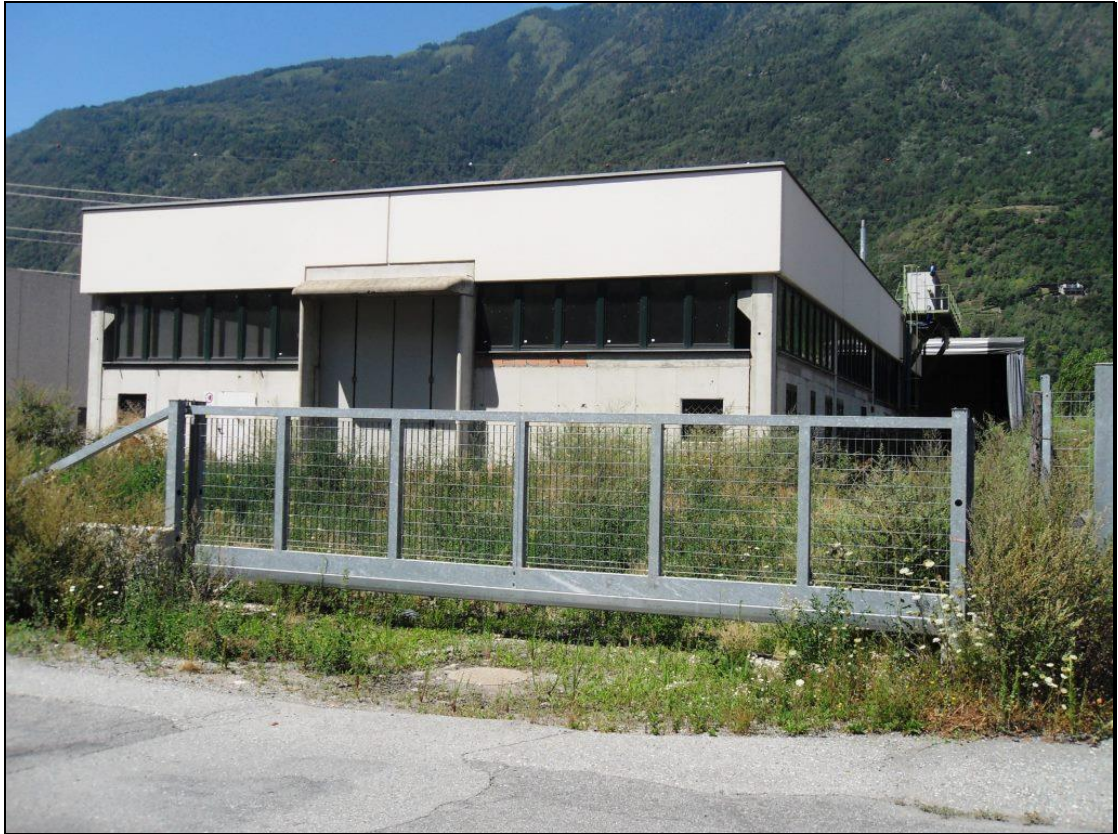
Fabbricato Fg. 42 mapp. 1191 sub. 1 visto da nord-est
