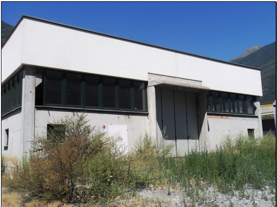
Facciata sud-est del fabbricato Fig. 42 mapp. 1191 sub. 1 (vista ravvicinata da sud)
