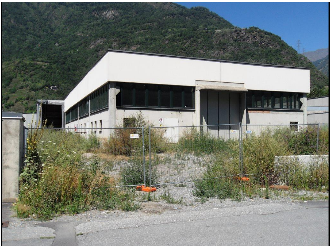
Fabbricato Fg. 42 mapp. 1191 sub. 1 visto da sud-est
