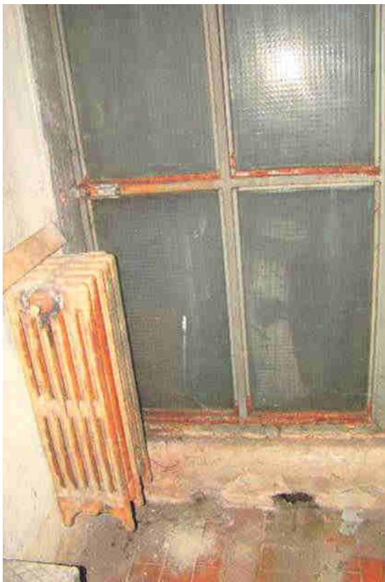
26. Dettaglio della porta che conduce all'esterno, in cortile.
