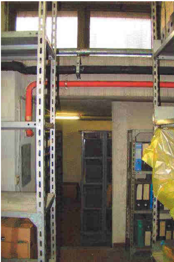
22. Vista del deposito.
