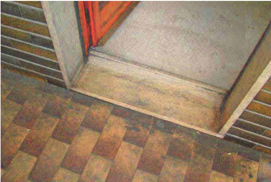
19. Dettaglio del pavimento esterno.
