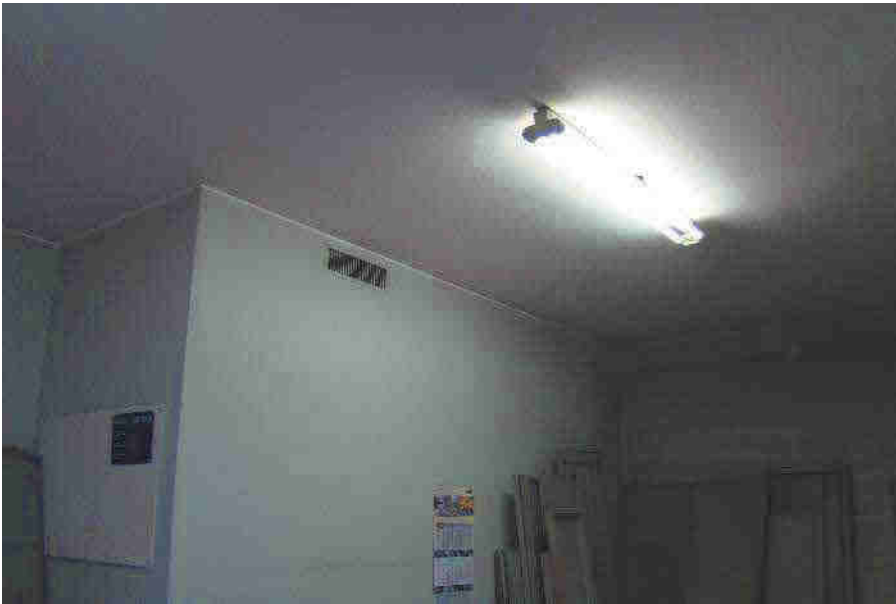
11. Vista di un altro locale.
