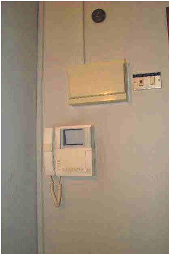
20. Dettaglio del videocitofono e degli impianti.
