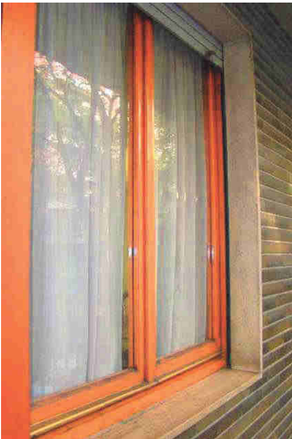
18. Dettaglio del serramento.
