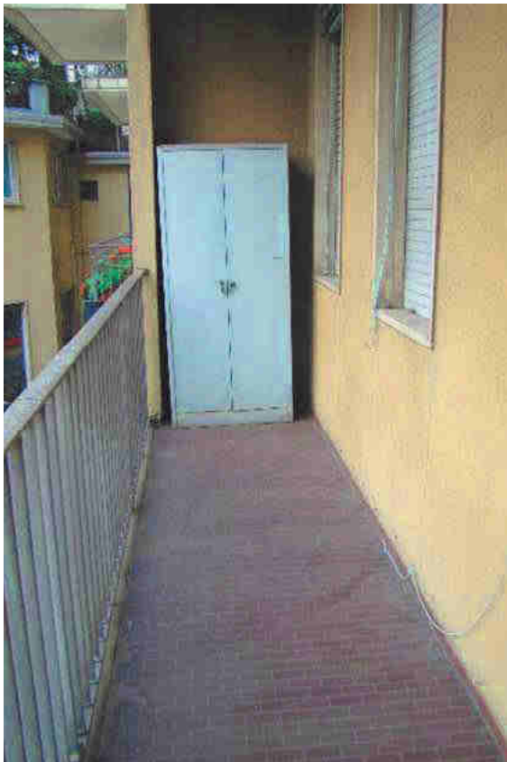
12. Vista della balconata con affaccio sul cortile interno.
