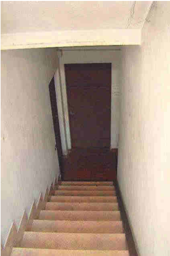
21. Vista della scala comune e delle porte di accesso al deposito.
