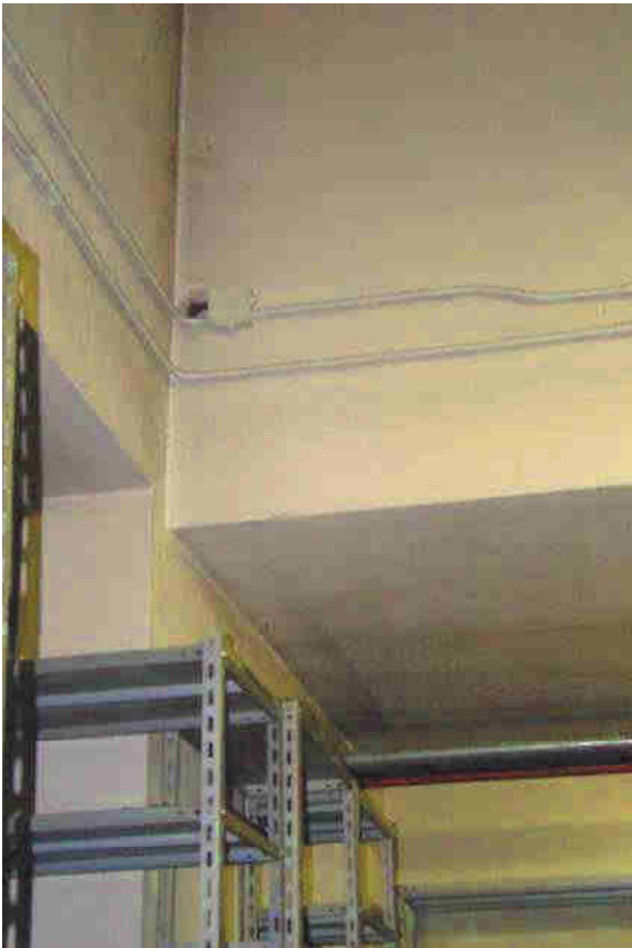
27. Dettaglio dei passaggi impiantistici esterni in canaline.
