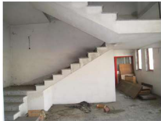
Fig. 48: scala tra il piano terra e il piano primo
