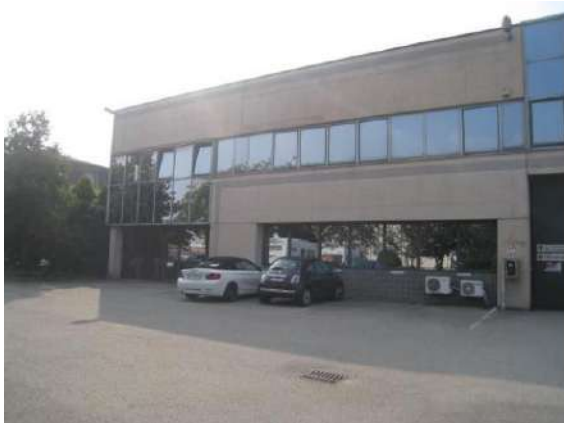
Fig. 10: capannone verso civico 13
