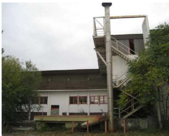
Fig. 44: il fabbricato lato cortile
