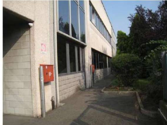
Fig. 11: capannone verso civico 45
