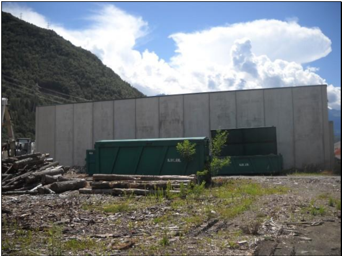
Facciata nord-est del fabbricato Fig. 55 mapp. 542, vista da nord-est
