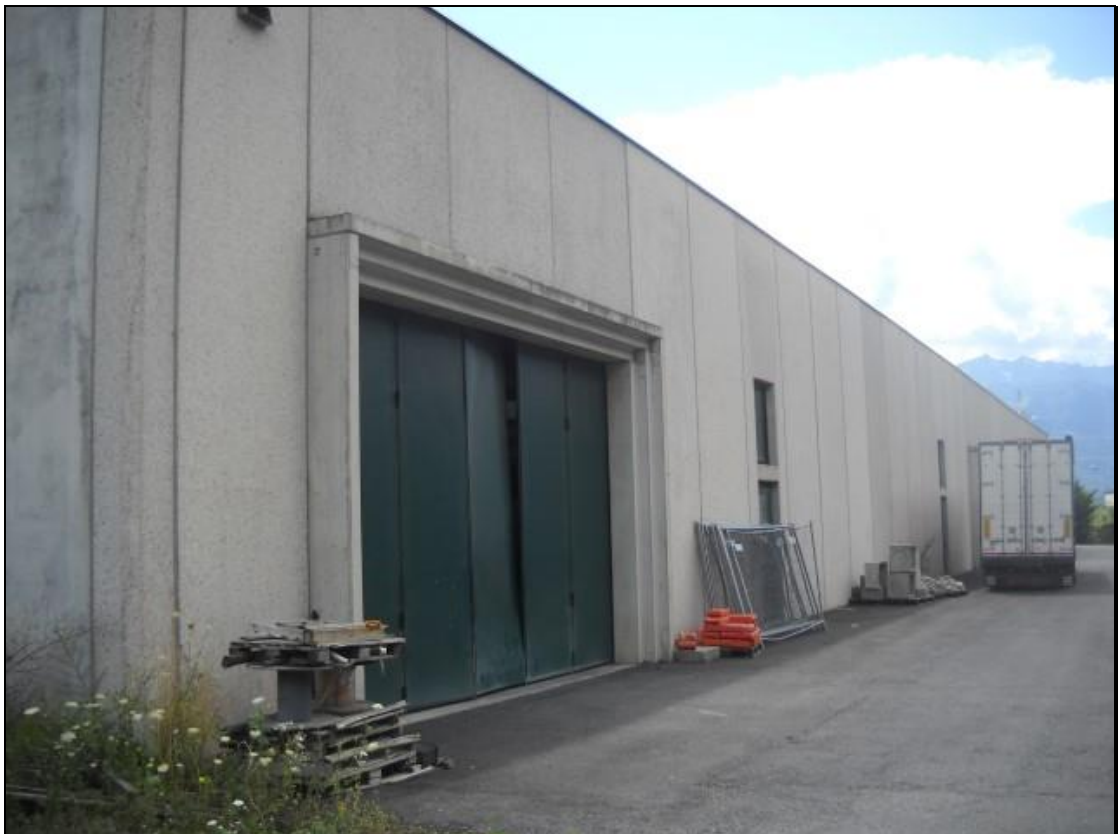
Facciata nord-ovest del fabbricato Fig. 55 mapp. 542, vista da nord-est
