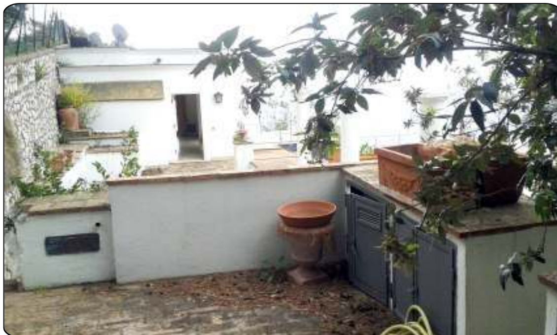
Foto 14- terrazzino su locale ext
