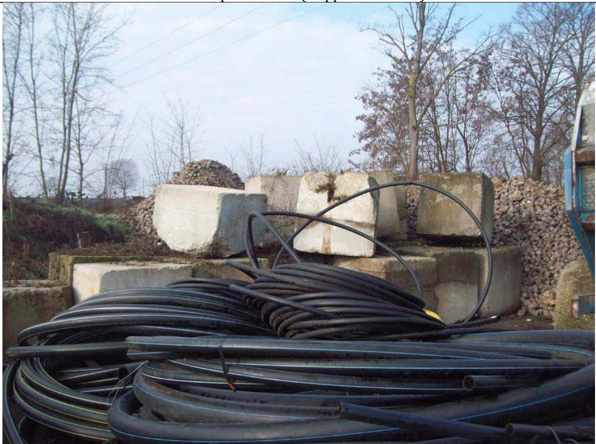
6- Area pavimentata (mappali 294 e 408)
