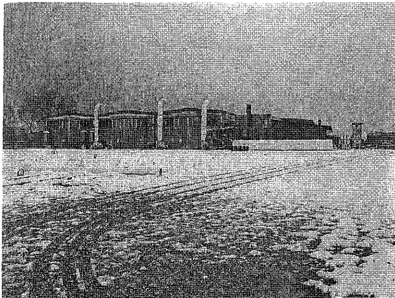
Vista dei capannoni di produzione da levante.
