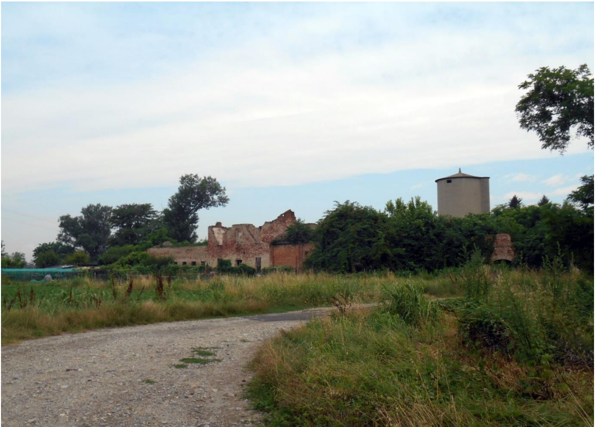
vista dei fabbricati collabenti presenti all'interno dell'area
