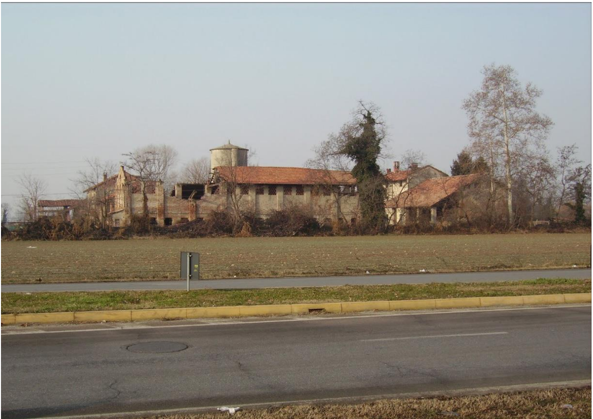
vista dei fabbricati collabenti presenti all'interno dell'area
