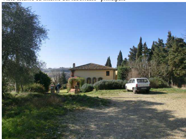
Viste esterne ed interne del fabbricato "principale"
