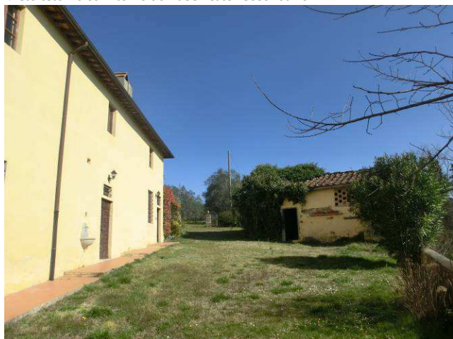
Viste esterne ed interne del fabbricato "secondario"
