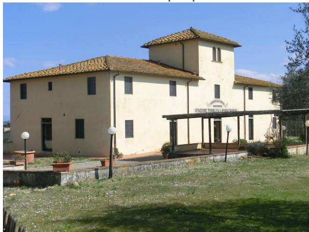
Viste esterne ed interne del fabbricato "principale"
