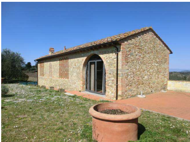
Viste esterne ed interne del fabbricato "secondario"
