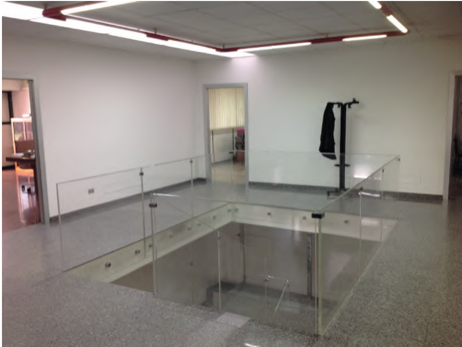
Scala di accesso – piano primo (uffici)
