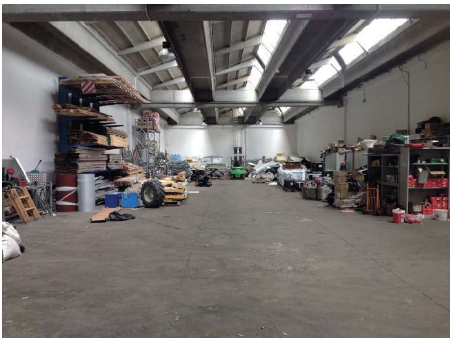
Vista interna del piano terreno
