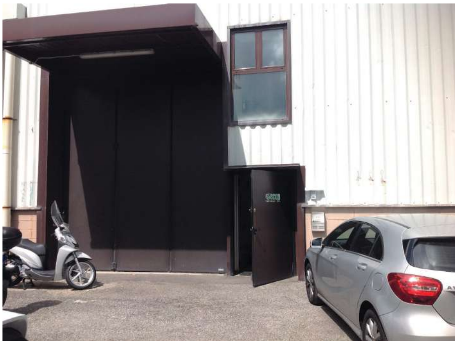
Accesso al locale
