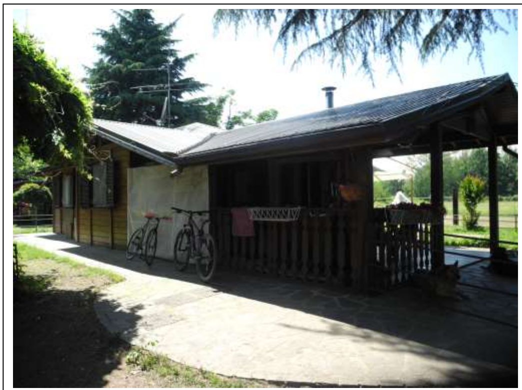
Fotografia n°1 – Vista del fronte Sud-Est del fabbricato.
