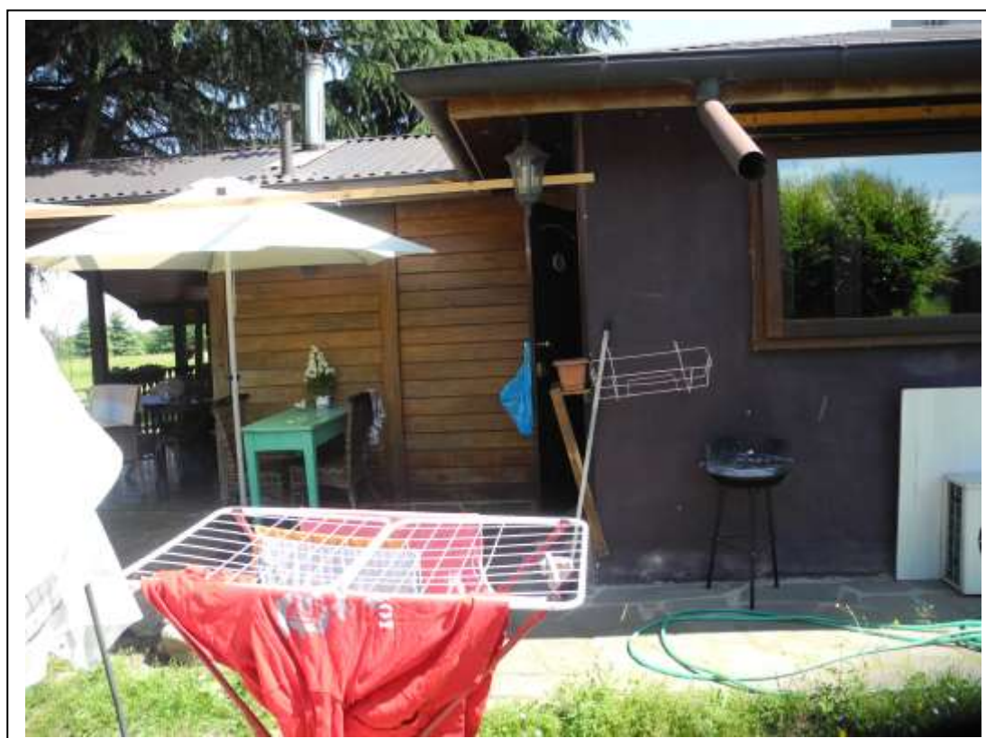
Fotografia n°4 – Vista del fronte Nord-Ovest del fabbricato.
