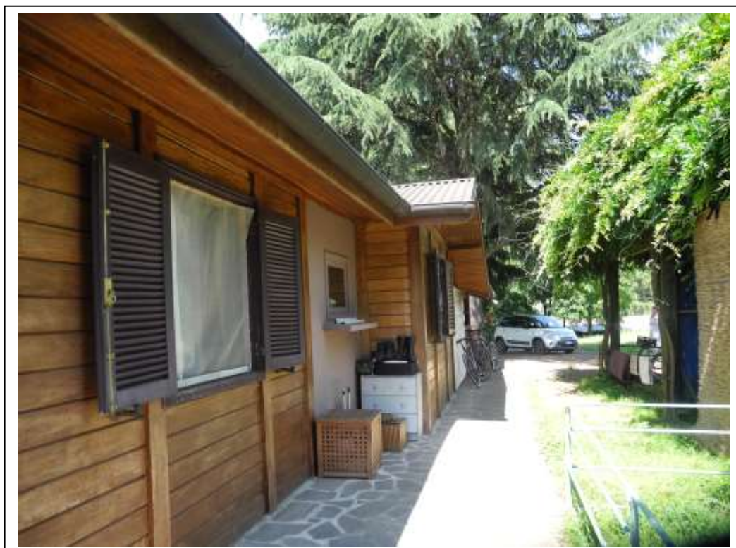
Fotografia n°2 – Vista del fronte Sud-Est del fabbricato.
