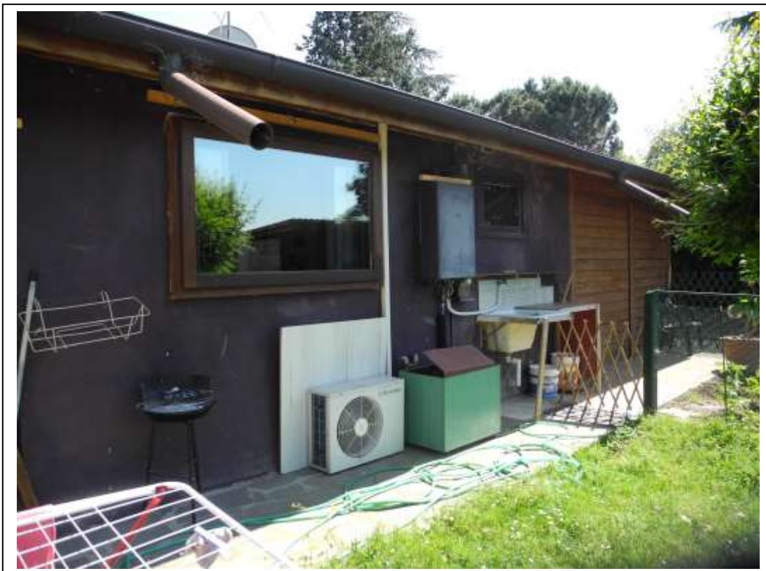
Fotografia n°3 – Vista del fronte Nord-Ovest del fabbricato.
