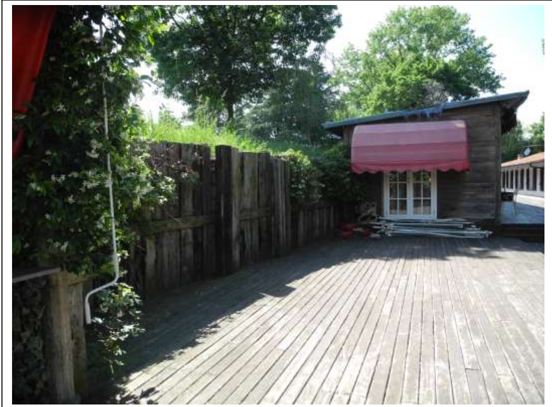
Fotografia n°3 – Vista del fronte Ovest del fabbricato e di uno degli accessi alla libreria.
