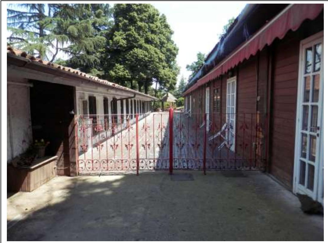
Fotografia n°1 – Vista del fronte Nord del fabbricato con accesso alle camere. (Di fronte fabbricato adibito a sala ristorante - Corpo 5)
