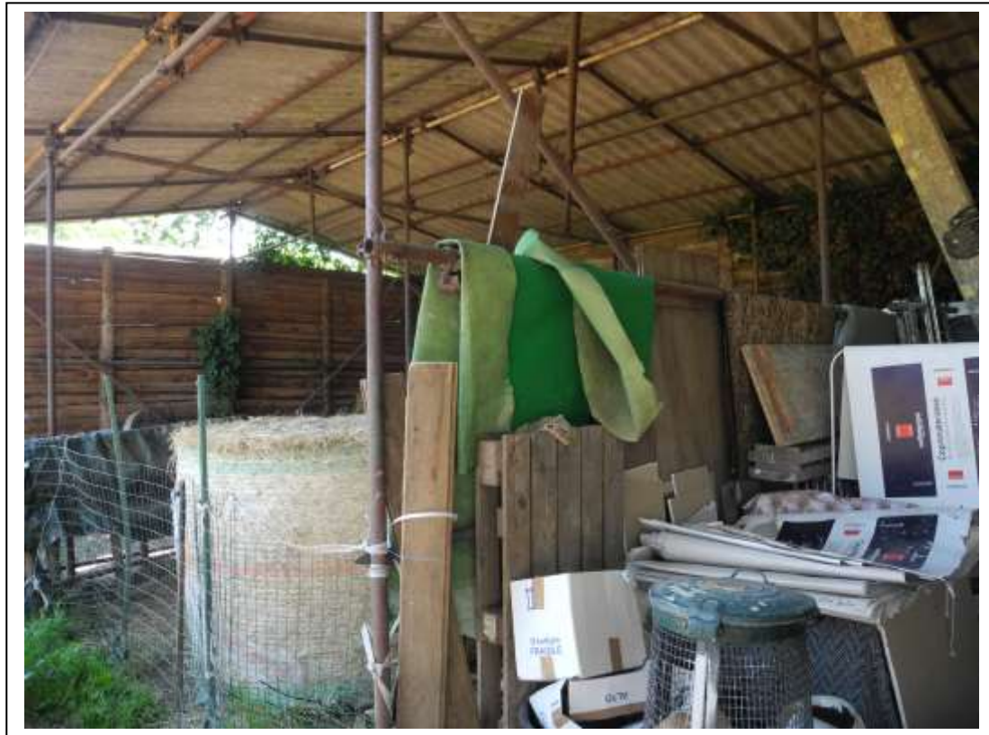
Fotografia n°4 – Vista della tettoia coperta.
