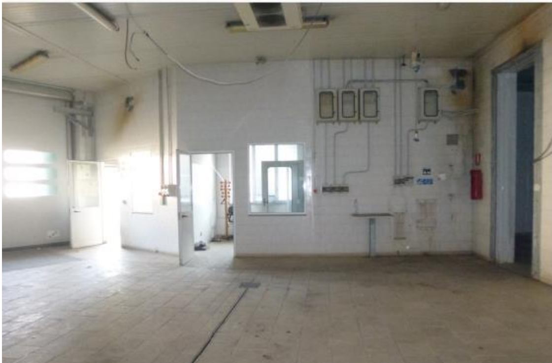
Interni capannone industriale
