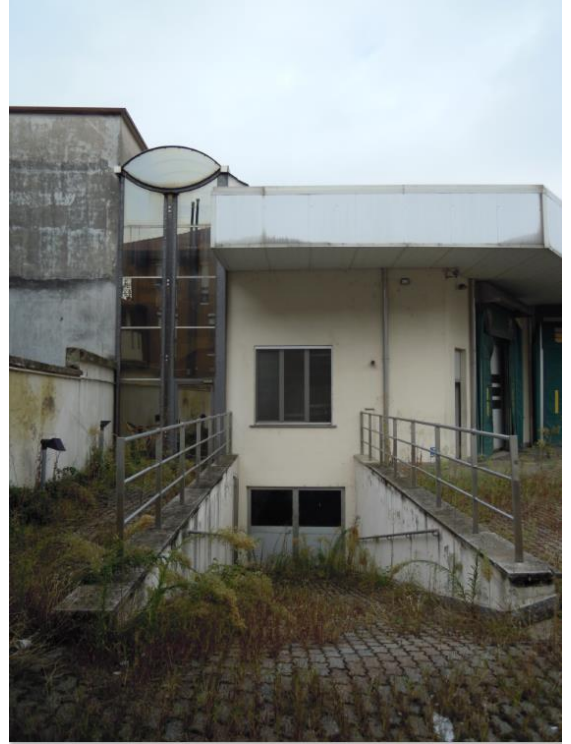
Rampa di accesso al piano interrato
