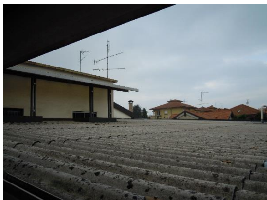
Copertura edificio industriale - in amianto
