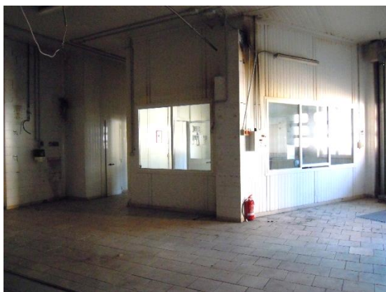
Locali al piano terra
