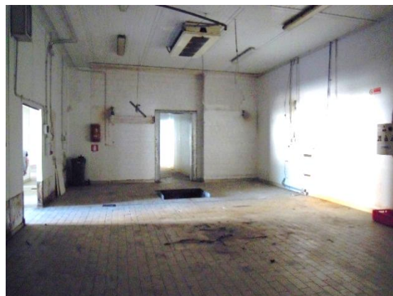
Locali al piano terra
