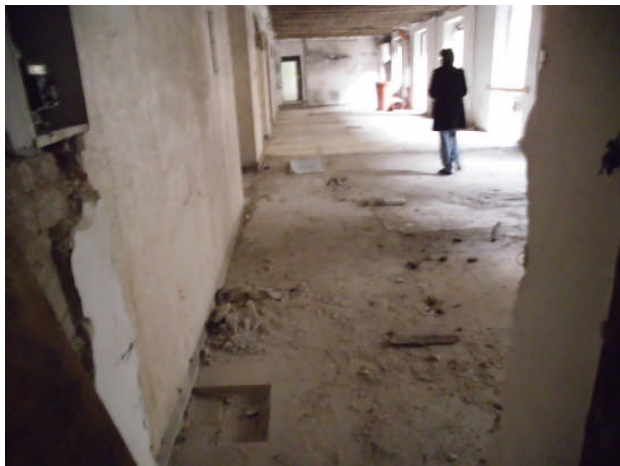
Foto 19 – Piano primo sovrastante il bar-ristorante
