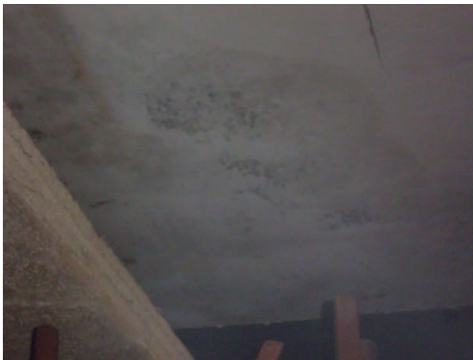
Foto 9 – soffitto e controsoffitto saletta verso corte
