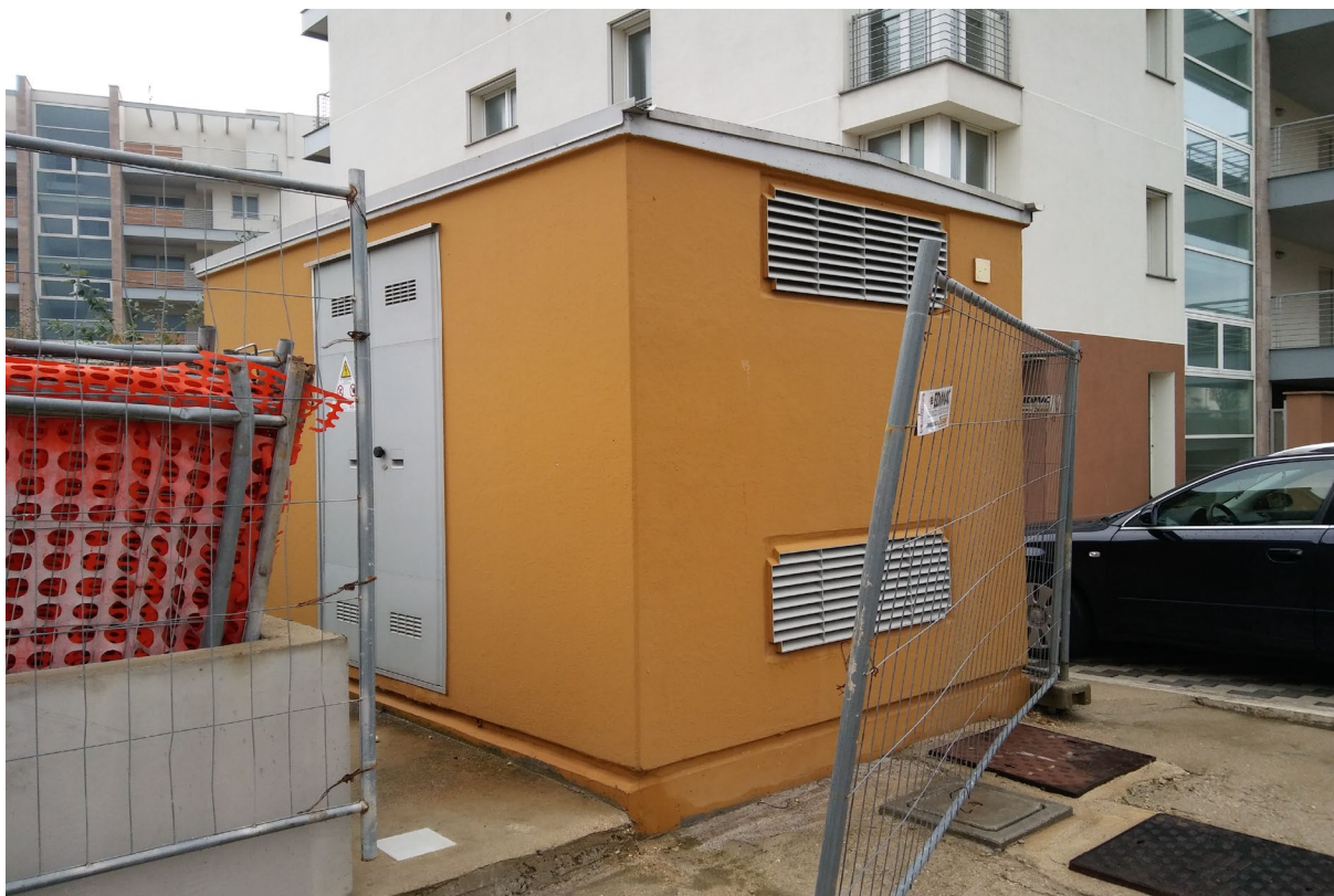
FOTO 01 - Vista della cabina elettrica dall'esterno.
