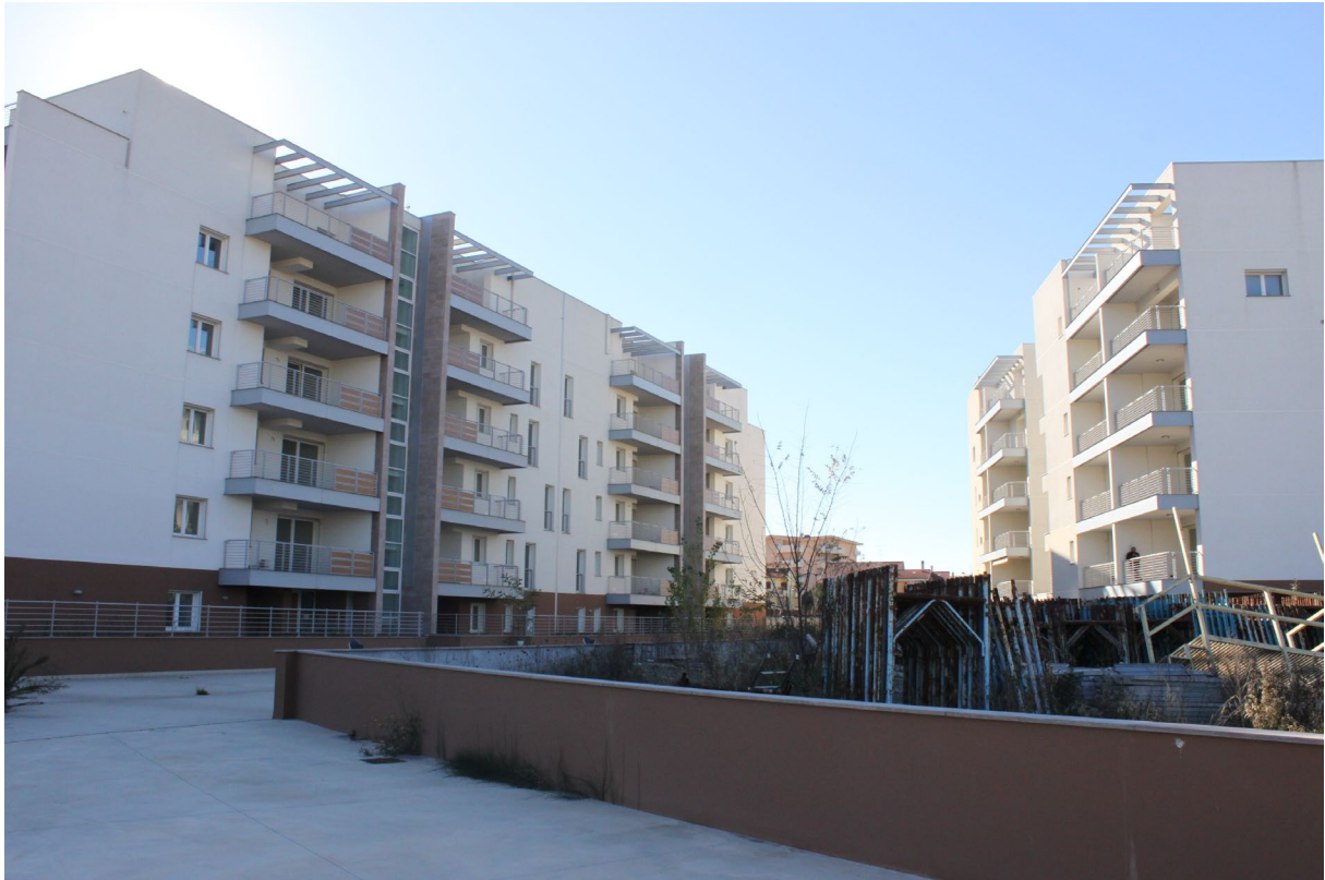
FOTO 05 - Vista dei fabbricati "A" e "B".
