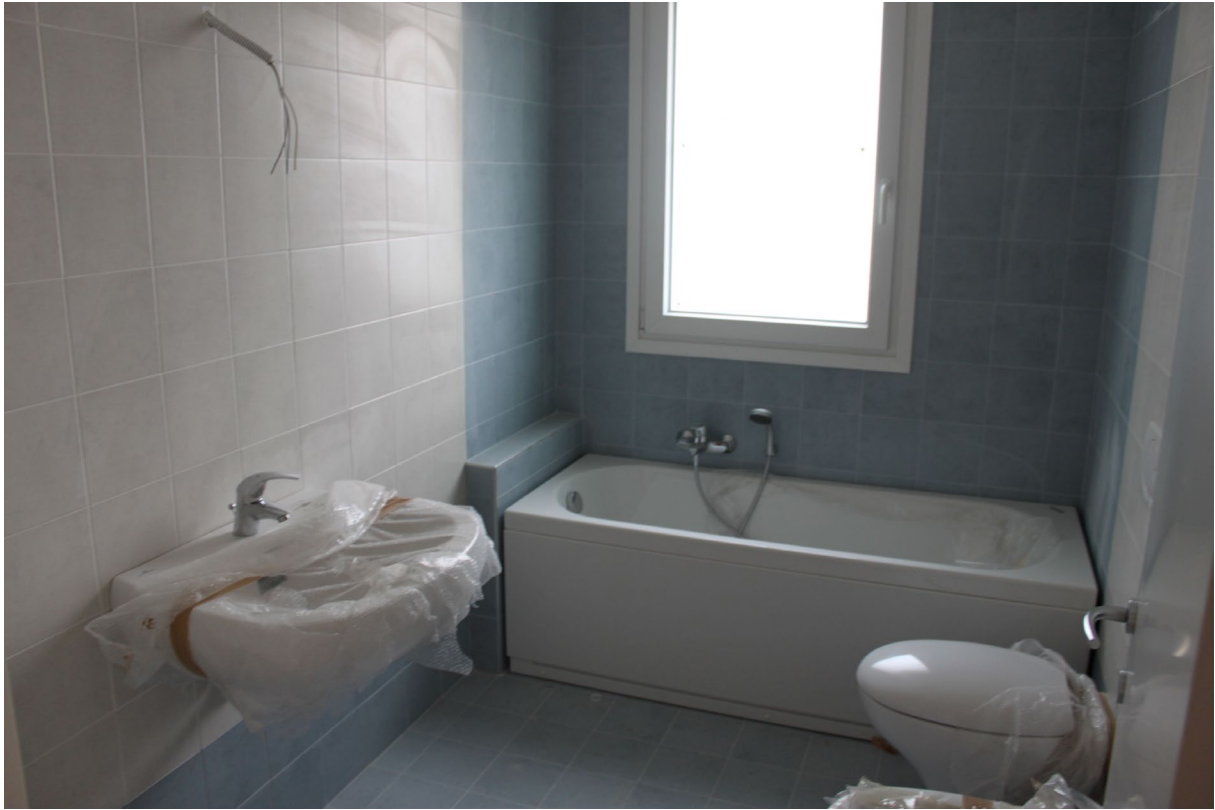
FOTO 09 - Vista del bagno di un appartamento.
