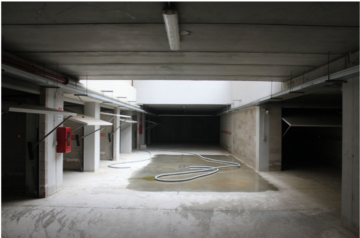
FOTO 12 - Vista dell'area di manovra al piano interrato.
