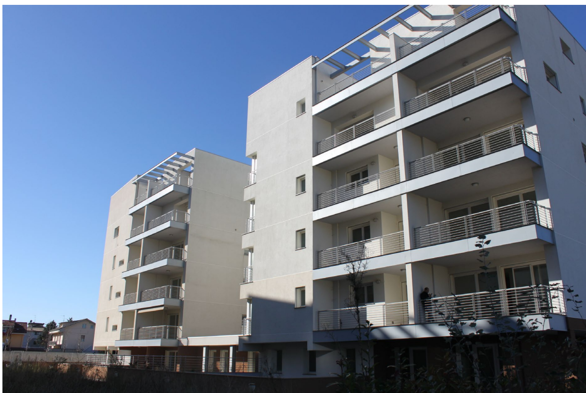
FOTO 04 - Vista del Fabbricato "A" dal cortile condominiale.
