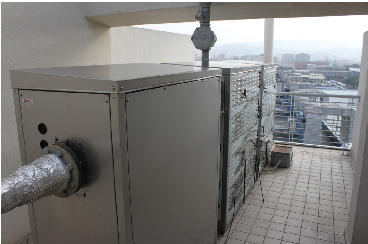
FOTO 06 - Vista del locale caldaia all'ultimo piano del fabbricato "B".
