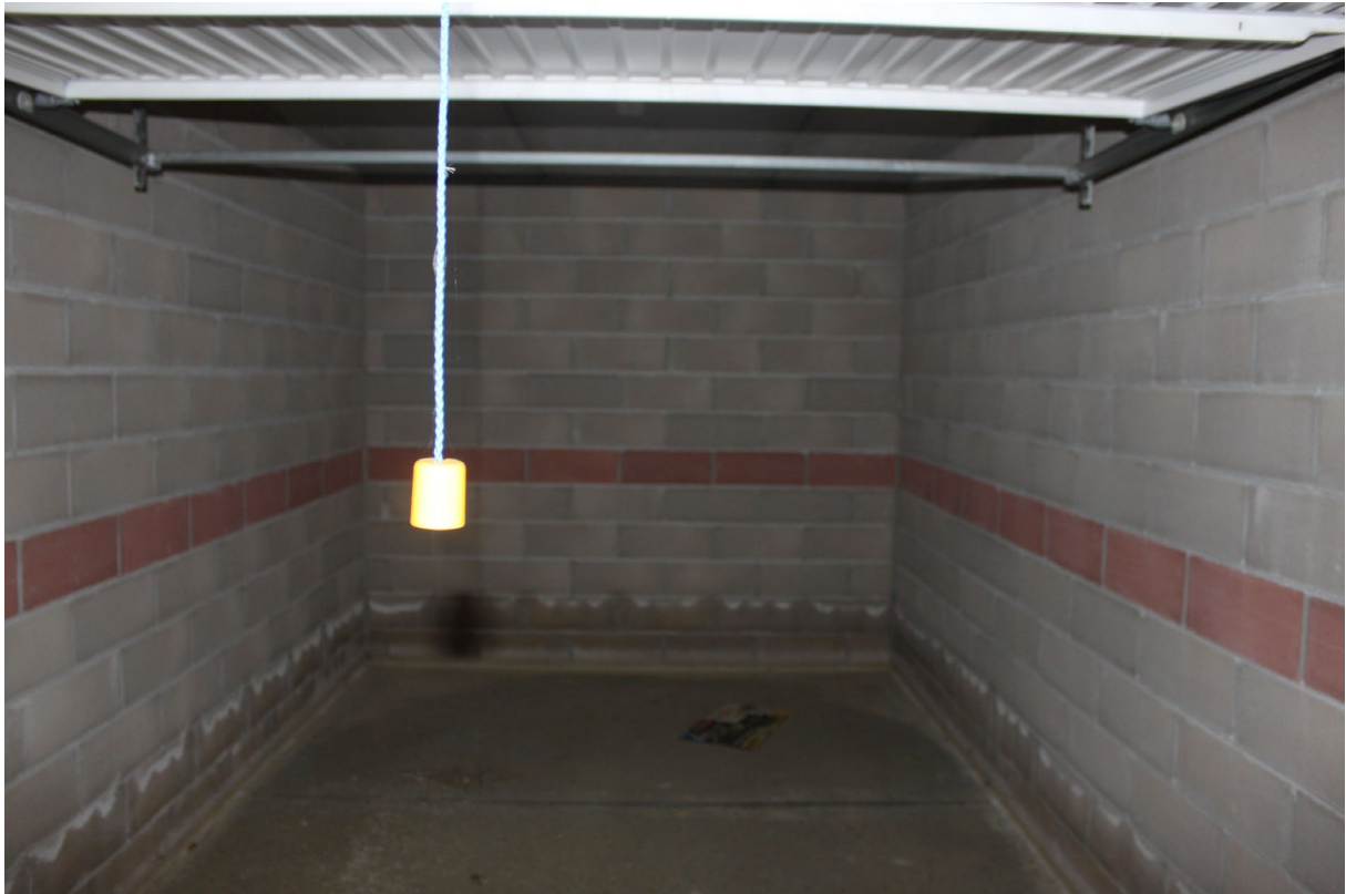
FOTO 11 - Vista di un autorimessa al piano interrato.
