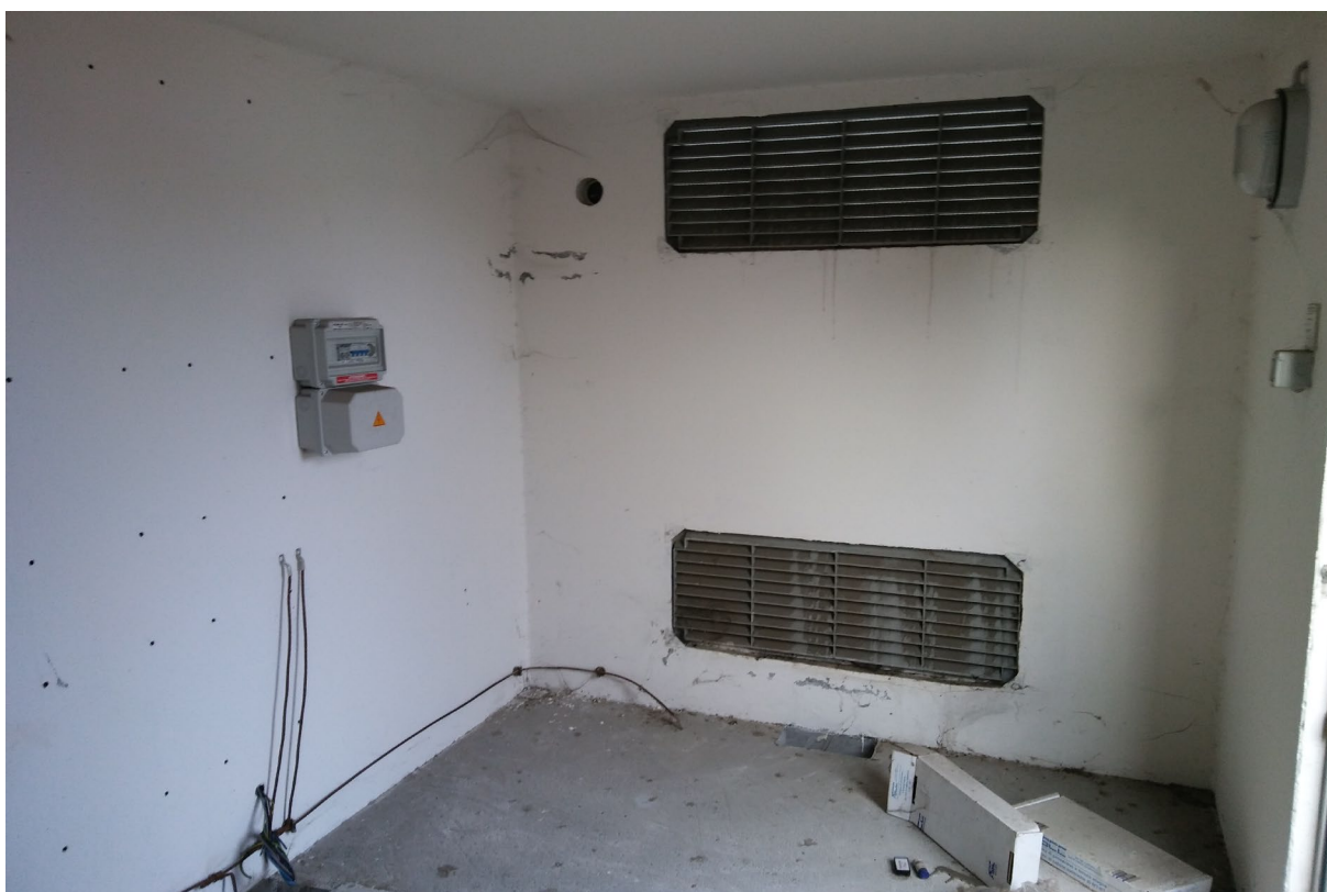
FOTO 02 - Vista della cabina elettrica dall'interno.
