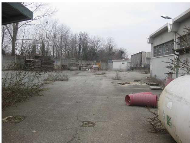
Area Cortilizia circostante il capannone
