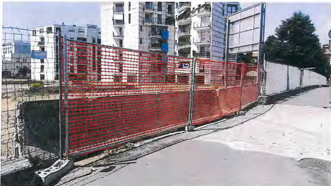
Posizionamento barriere new jersey
