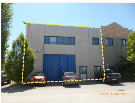
Contornato in giallo l'edificio oggetto di stima
