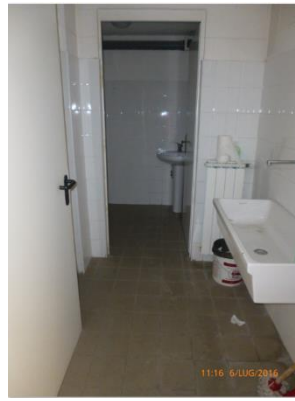
Bagno al piano terra
