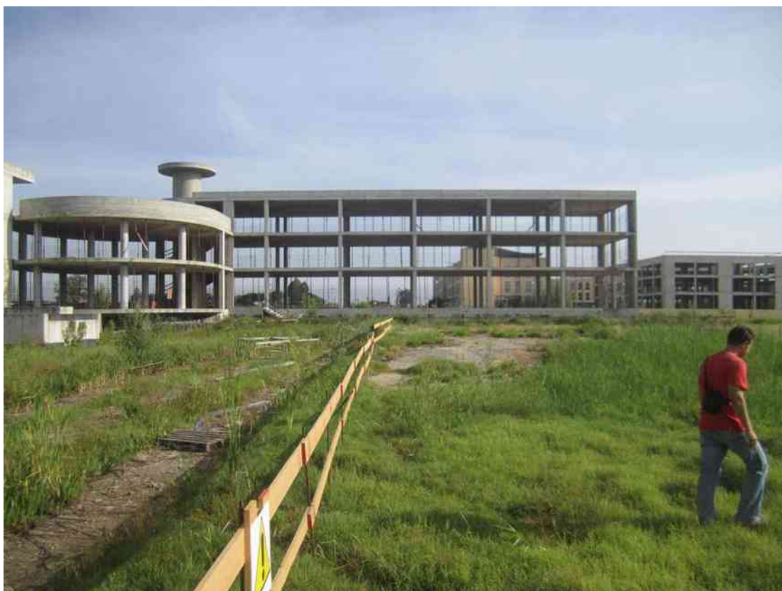
Foto n.7 – Corpi 8A-a (vista dal lato ferrovia)
