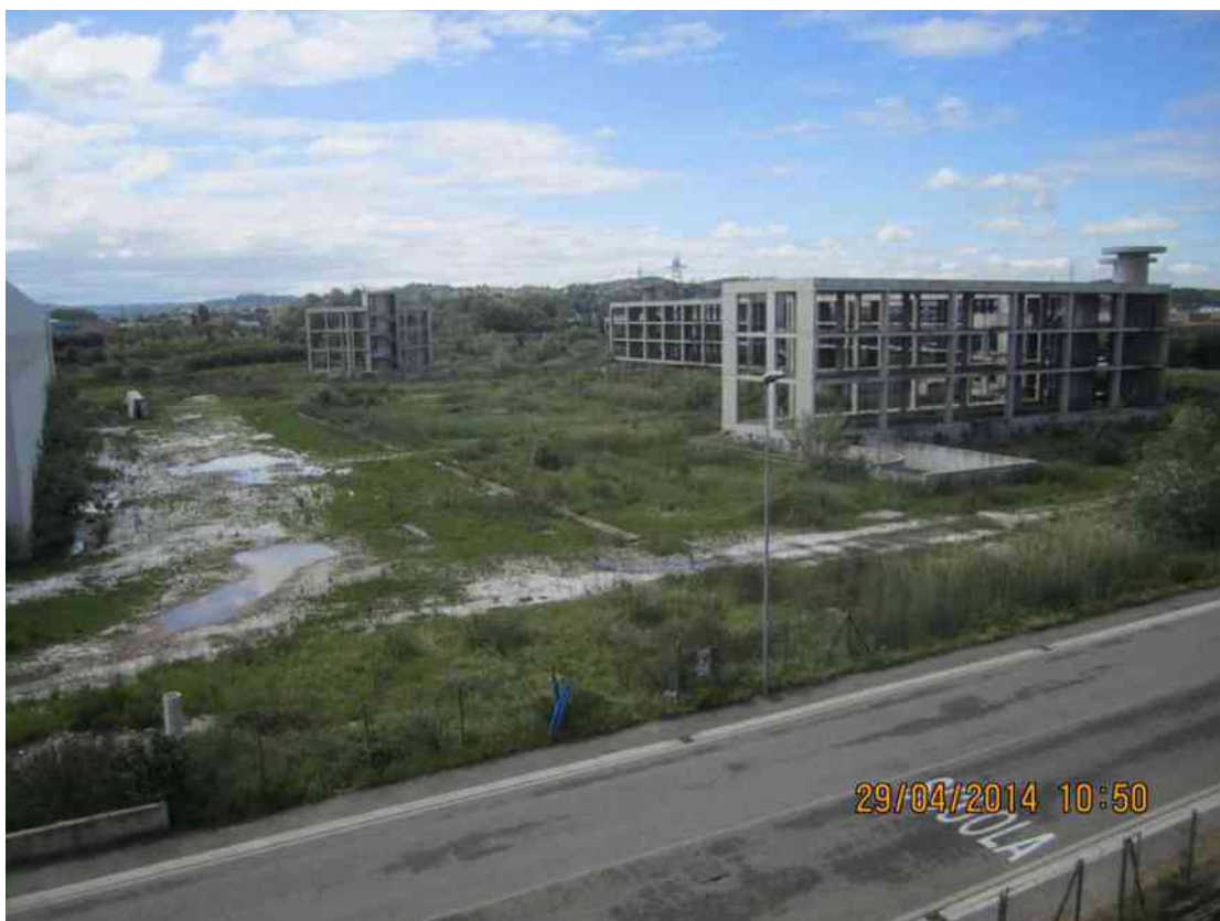
Foto n.4 - Vista generale dal lotto 2A
