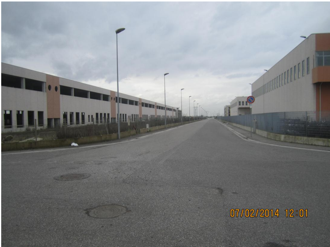
Foto n.3 - Vista del fronte su Via Marco Polo
