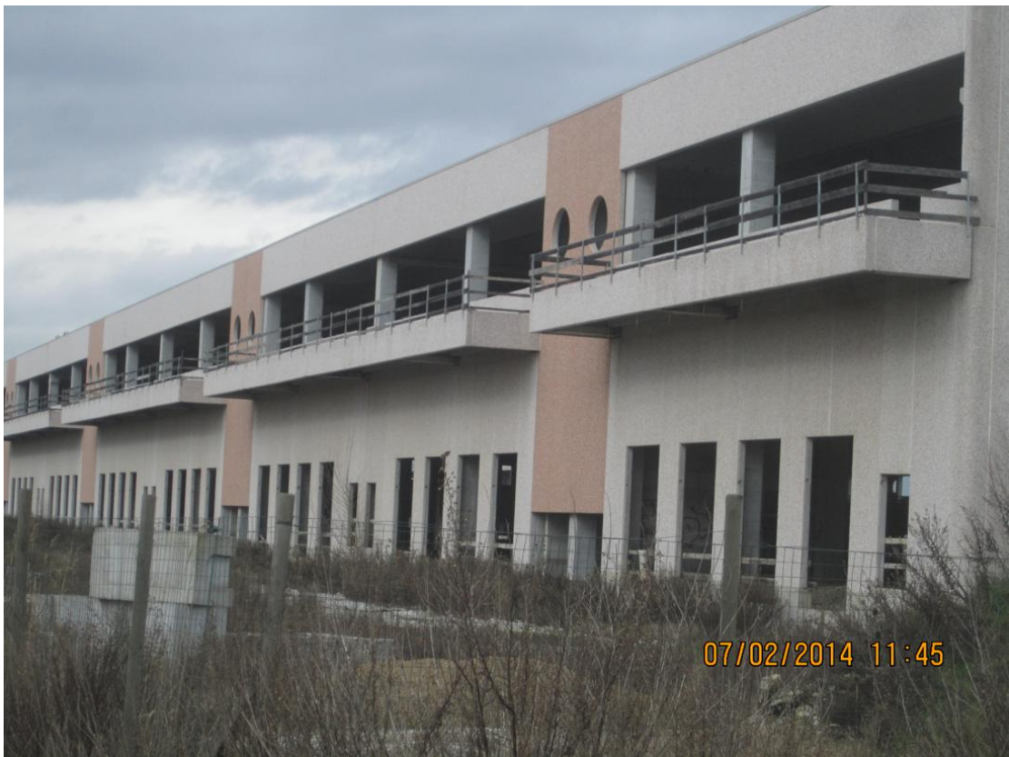
Foto n.6 - Prospetto tergale (vista dalla ferrovia)
