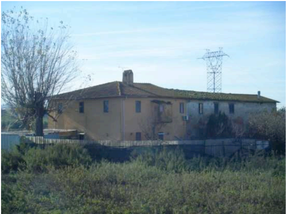
Foto n.5 - Vista del Prospetto lato lotto 5
