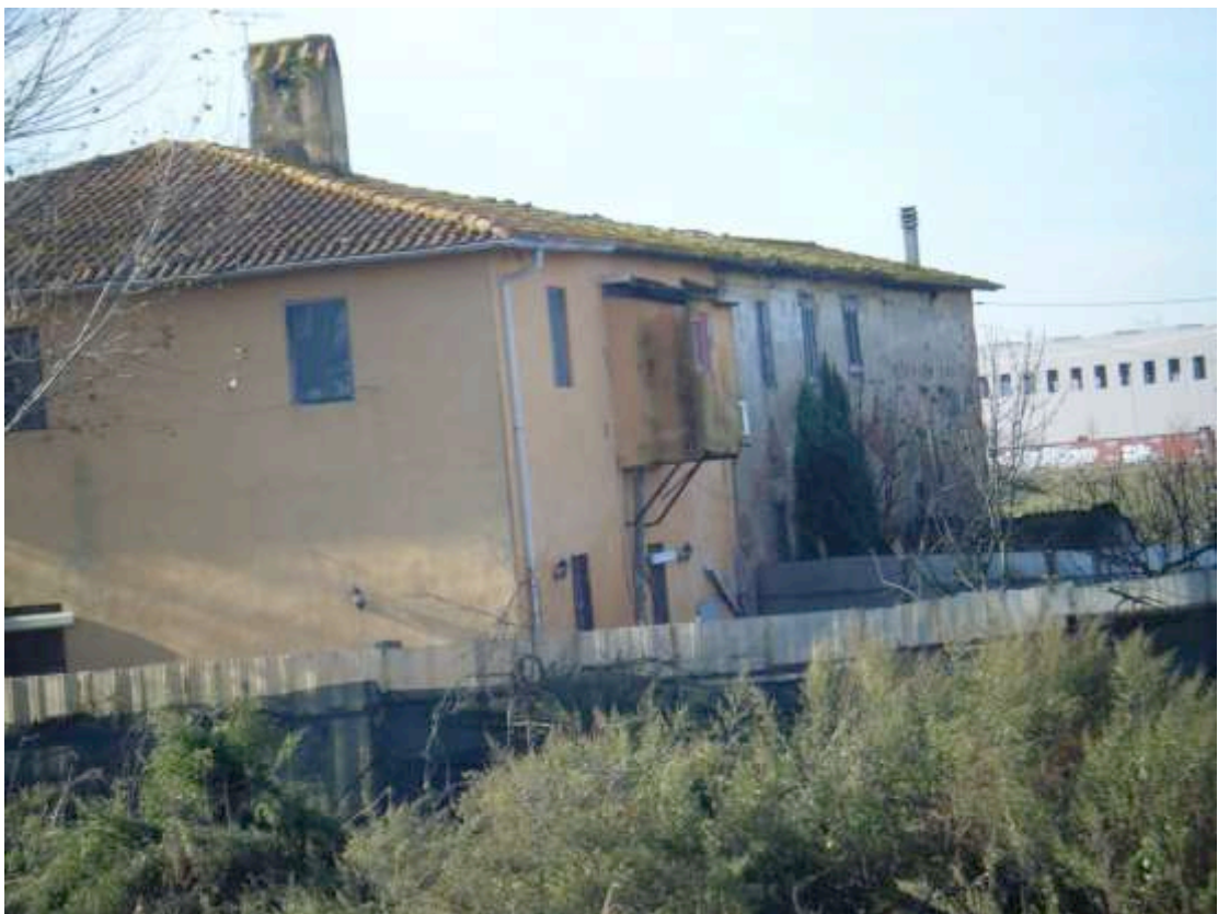
Foto n.6 - Dettaglio del prospetto di cui alla foto recedente
